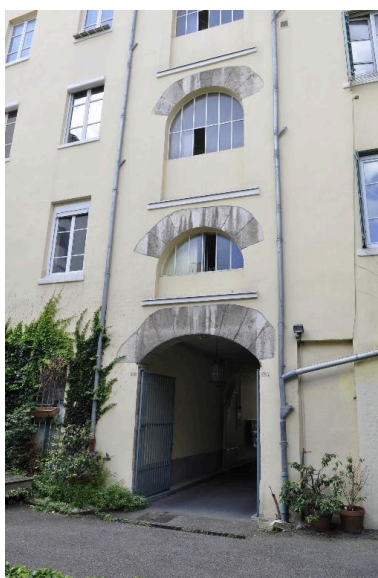
Elévation sur cour, vue partielle de la cage d'escalier
