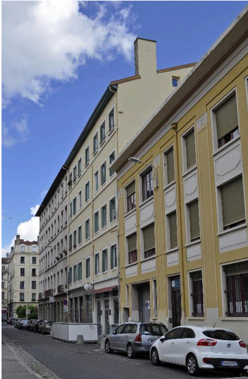
Vue d'ensemble de l'élévation sur rue
