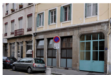
Elévation sur rue, vue rapprochée du rez-de-chaussée Phot. Catherine Guégan IVR84_20166900745NUCA
