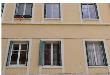
Elévation sur rue, vue rapprochée d'un étage (encadrements de baies partiellement obturés) Phot. Catherine Guégan IVR84_20166900746NUCA
