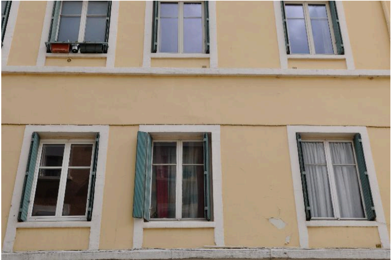
Elévation sur rue, vue rapprochée d'un étage (encadrements de baies partiellement obturés)
