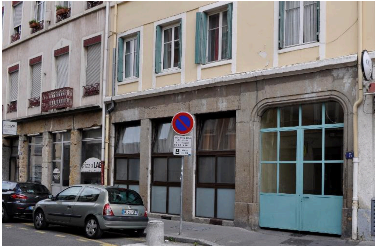
Elévation sur rue, vue rapprochée du rez-de-chaussée
