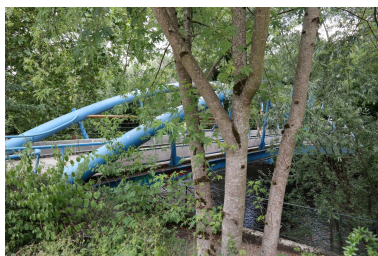
Passerelle piétonne sur le Thiou, vue de la face aval Phot. Pascale Renard IVR84_20207403843NUCA
