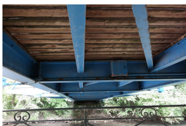
Passerelle piétonne sur le Thiou, vue de sous le tablier Phot. Pascale Renard IVR84_20207403846NUCA
