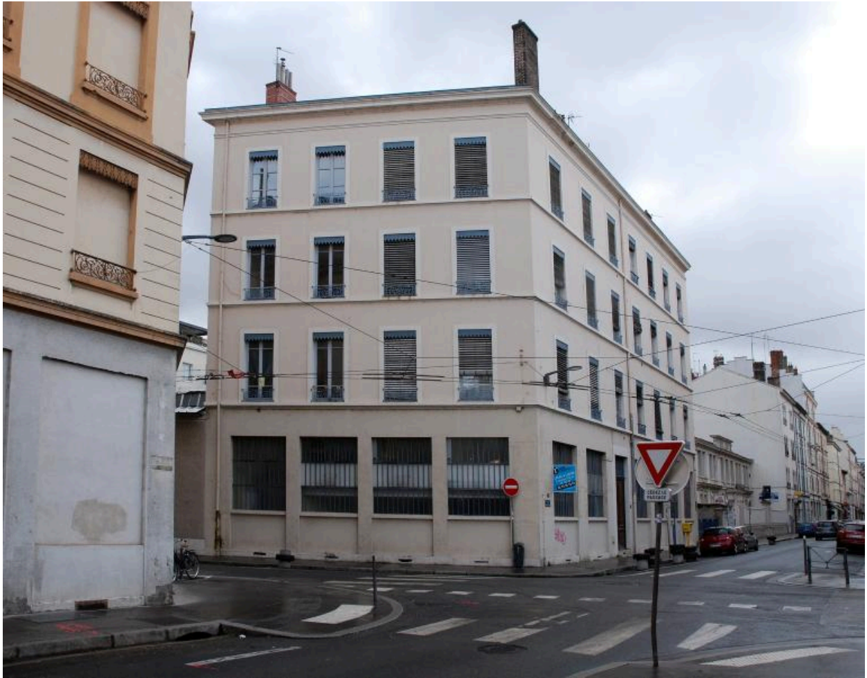
Vue générale de l'immeuble
