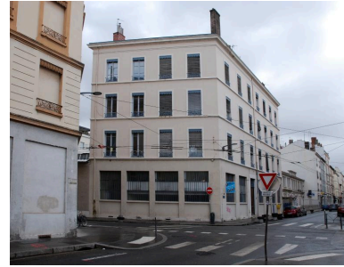
Vue générale de l'immeuble Phot. Catherine Guégan IVR84_20186900263NUCA
