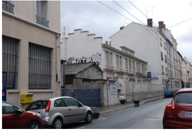
Vue générale nord-ouest de l'ancien garage Phot. Catherine Guégan IVR84_20176902226NUCA
