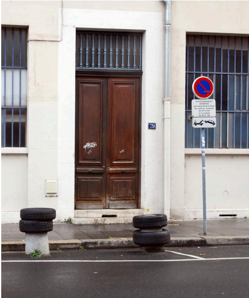
Immeuble : détail de la porte d'entrée
