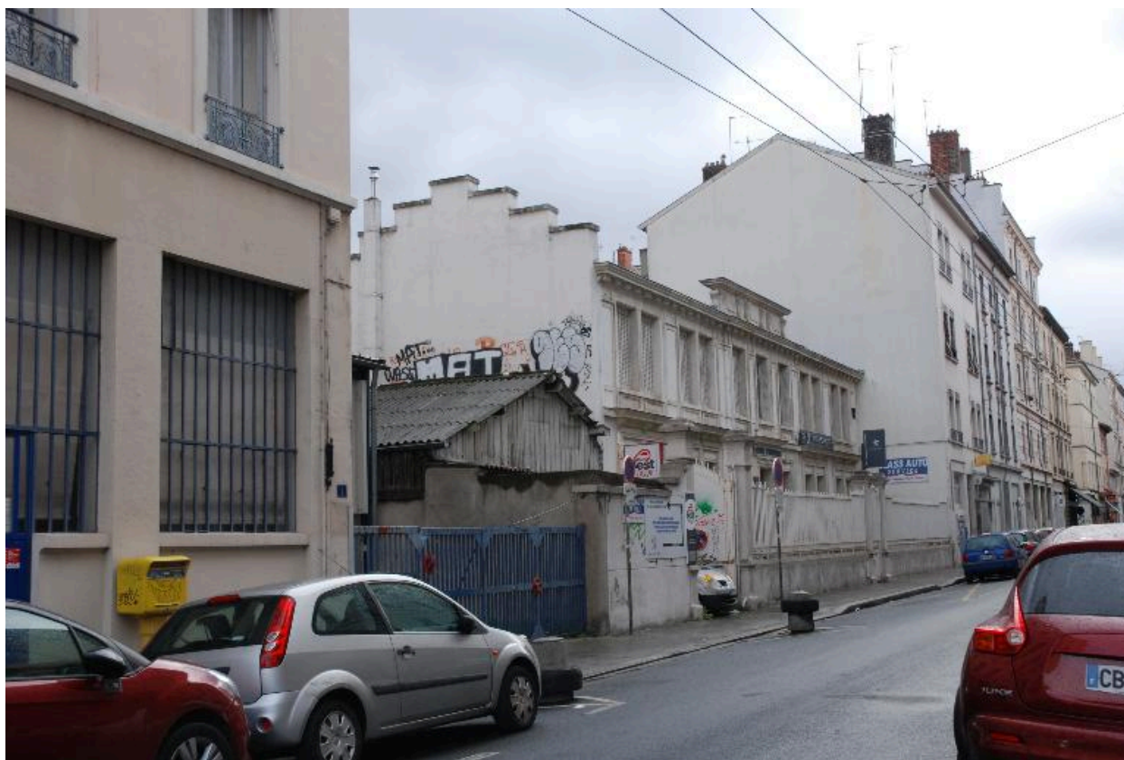
Vue générale nord-ouest de l'ancien garage
