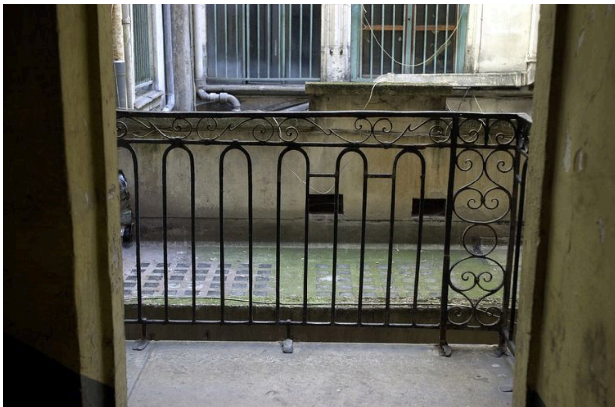
Coursière sur cour du premier étage, vue depuis le palier de l'escalier
