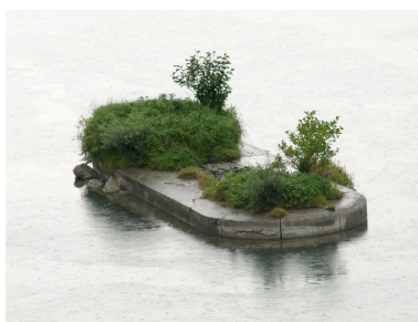
Vestige de pile dans le fleuve, en aval du pont routier (depuis la rive gauche) Phot. J. Marasi IVR82_20100100224NUCA
