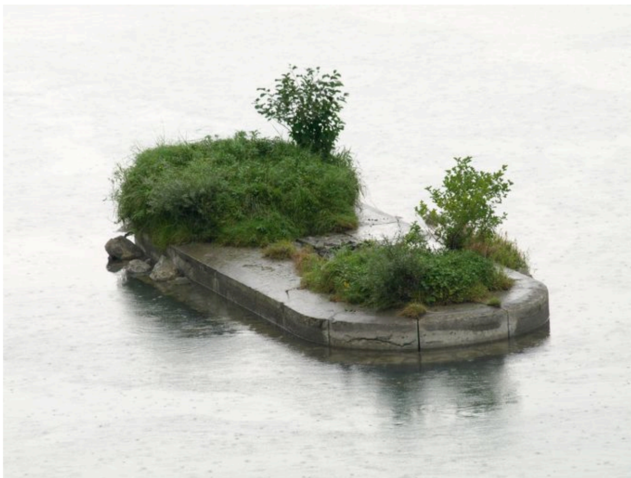
Vestige de pile dans le fleuve, en aval du pont routier (depuis la rive gauche)
