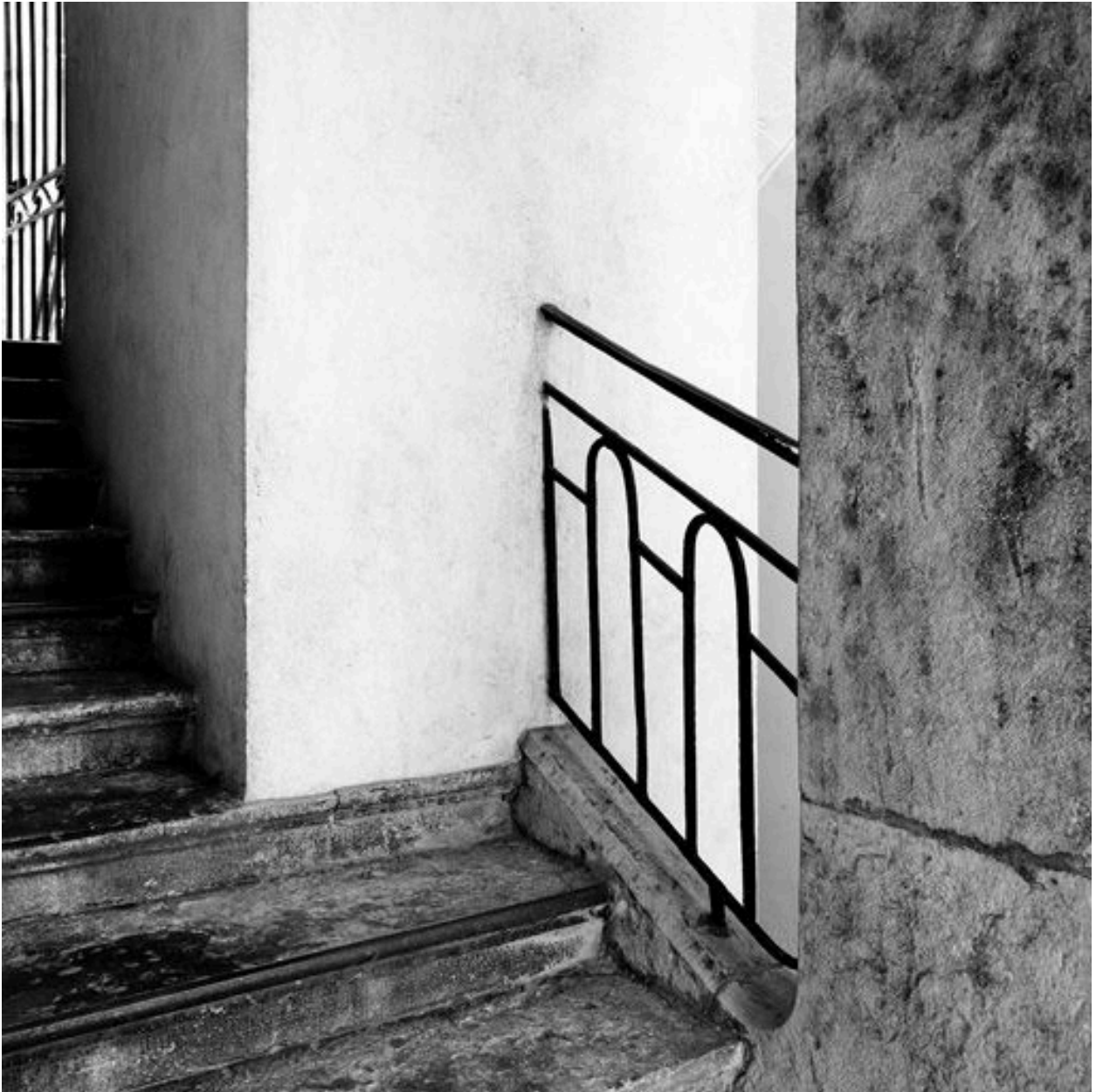
Rez-de-chaussée de l'escalier, détail du noyau subsistant
