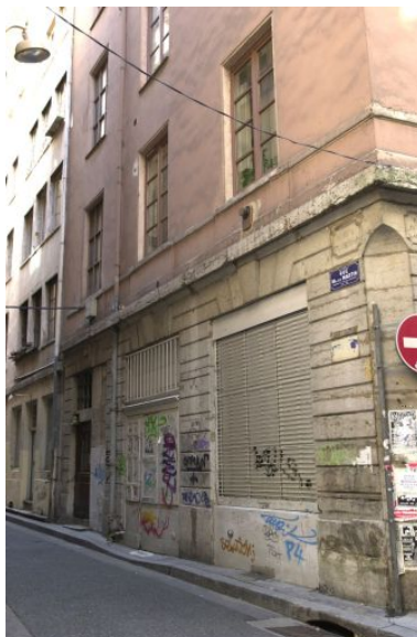
Façade sur la rue du Major- Martin, rez-de-chaussée Phot. Maryannick Chalabi IVR82_20036901044NUCA
