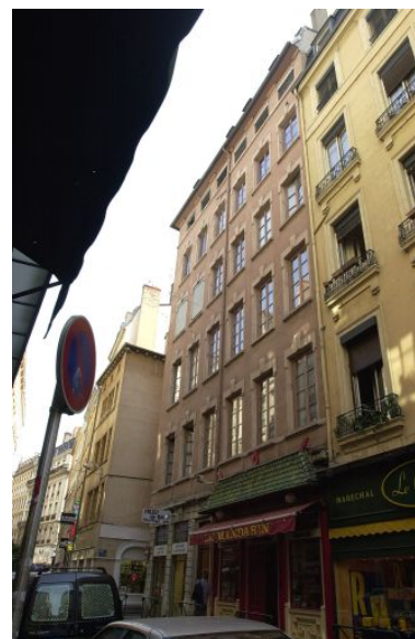
Façade principale sur la rue Lanterne Phot. Lore Derail IVR82_20036901354NUCA
