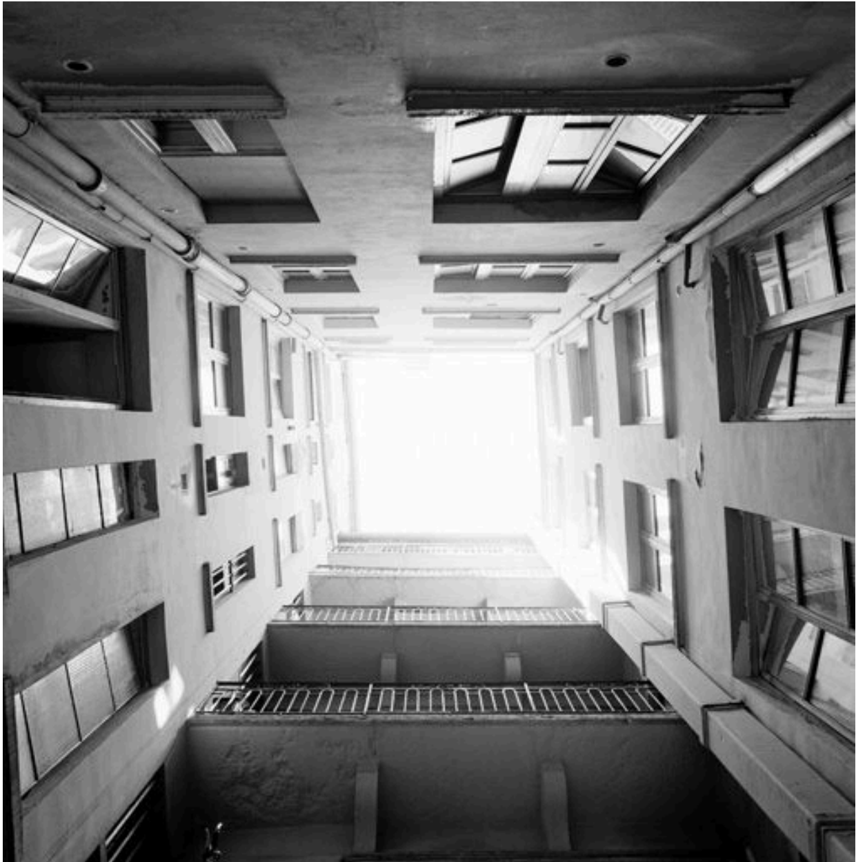
Cour, vue générale par-dessous
