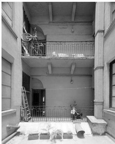
Cour, coursières des 1er et 2e étages Phot. Didier Gourbin IVR82_20056902505V
