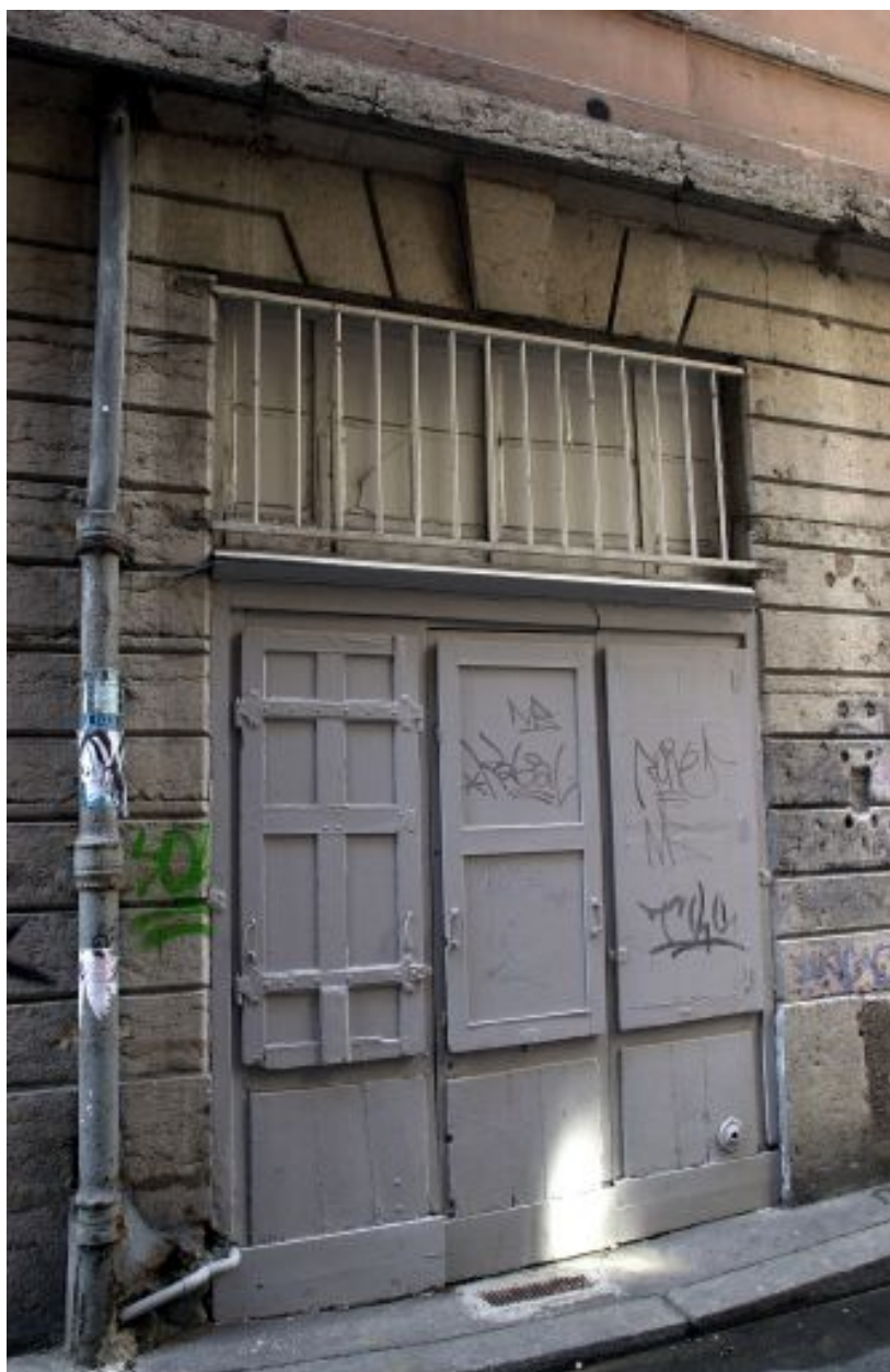
Façade sur la rue du Major-Martin, ouverture de boutique
