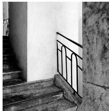
Rez-de-chaussée de l'escalier, détail du noyau subsistant Phot. Didier Gourbin IVR82_20056902506X
