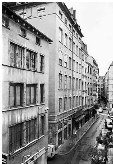
Façade sur la rue Lanterne (à droite) Phot. Eric Dessert IVR82_20046900559P
