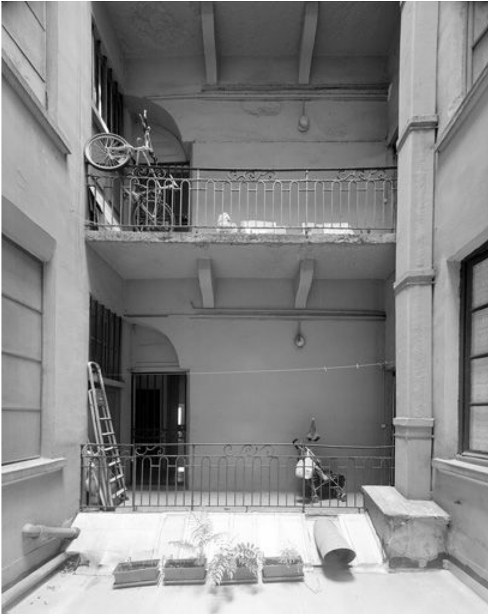
Cour, coursières des 1er et 2e étages
