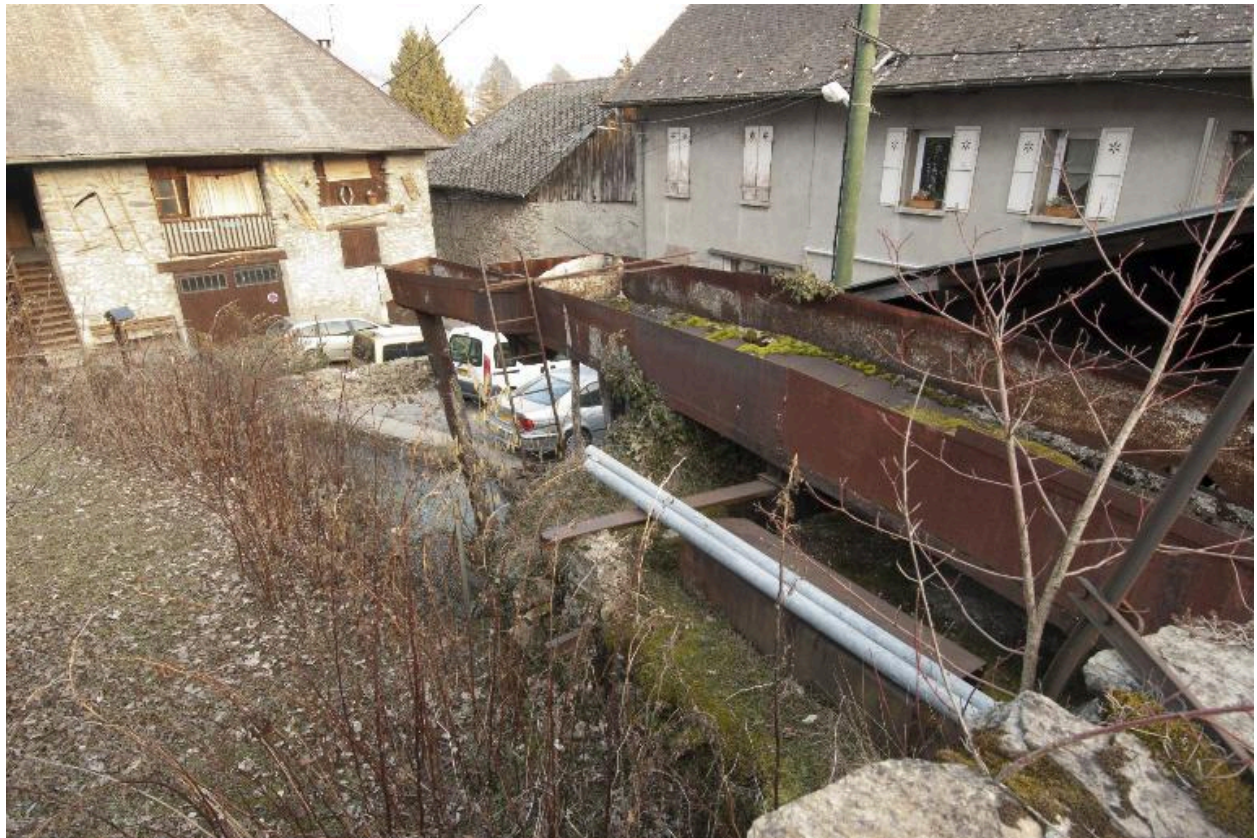
Canal d'amenée au dessus de la roue et de la trompe, actuellement démonté, 2011.
