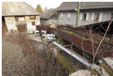
Canal d'amenée au dessus de la roue et de la trompe, actuellement démonté, 2011. Phot. Jean-François Laurenceau IVR82_20157301646NUCA
