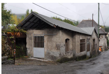
Vue de la forge des Allues, 2009. Phot. Jean-François Laurenceau IVR82_20157301625NUCA
