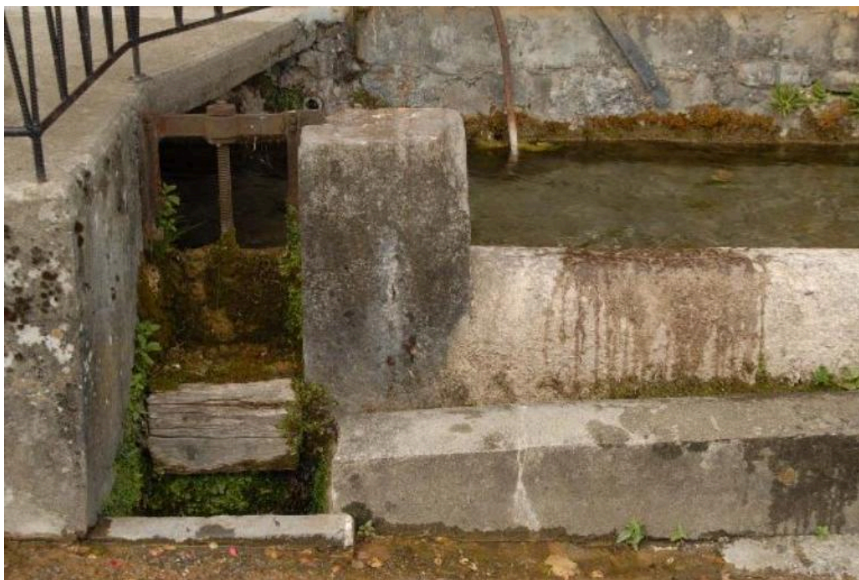
Vanne-déversoir en amont de la forge, 2009.
