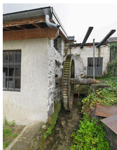
Vue de la grande roue hydraulique, 2019. Phot. Thierry Leroy IVR84_20197301983NUCAQ
