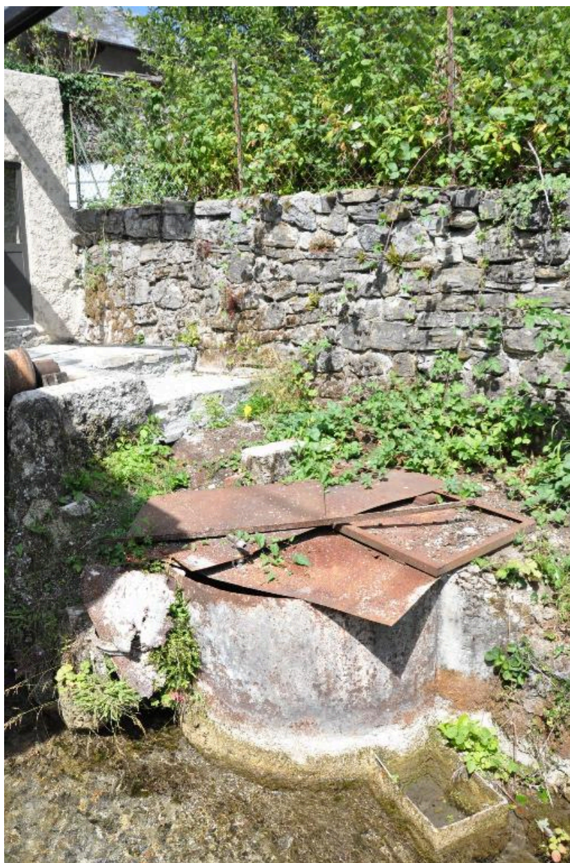
Vestiges de la trompe hydraulique, 2014.
