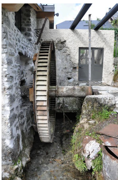
Vue de la grande roue hydraulique, 2014. Phot. Clara Bérelle IVR82_20157301632NUCA
