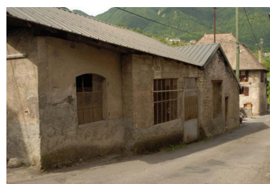
Vue de la forge des Allues, 2009. Phot. Jean-François Laurenceau IVR82_20157301626NUCA
