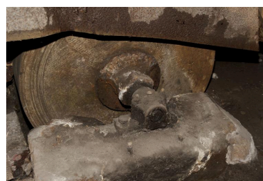
Détail du palier de l'arbre à cames, 2011. Phot. Jean-François Laurenceau IVR82_20157301645NUCA
