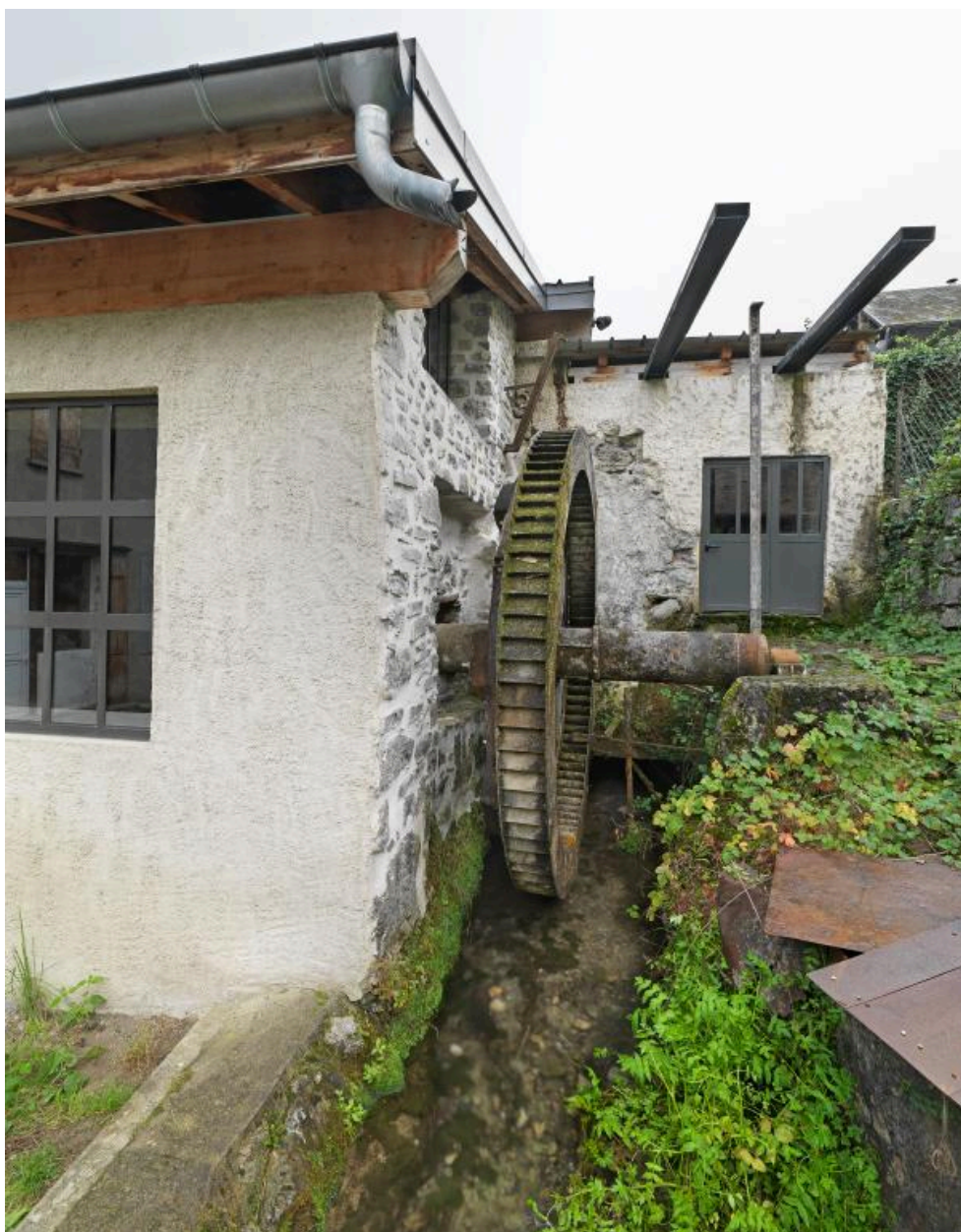
Vue de la grande roue hydraulique, 2019.
