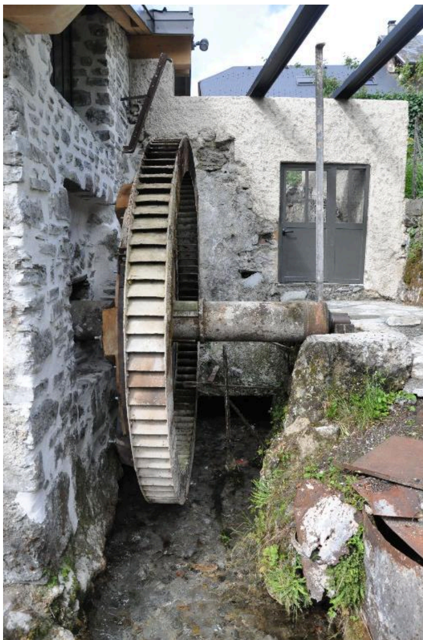
Vue de la grande roue hydraulique, 2014.
