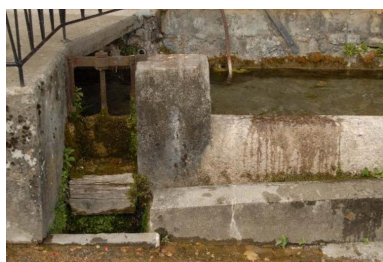
Vanne-déversoir en amont de la forge, 2009. Phot. Jean-François Laurenceau IVR82_20157301627NUCA
