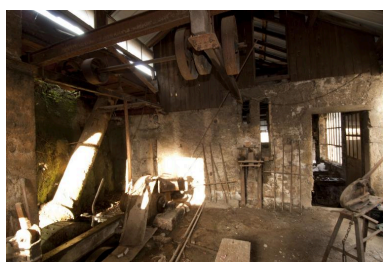
Vue intérieure de la forge, 2011. Phot. Jean-François Laurenceau IVR82_20157301643NUCA
