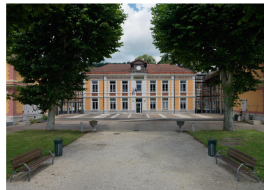
Bâtiment de l'administration Phot. Thierry Leroy IVR84_20213800200NUCAQ
