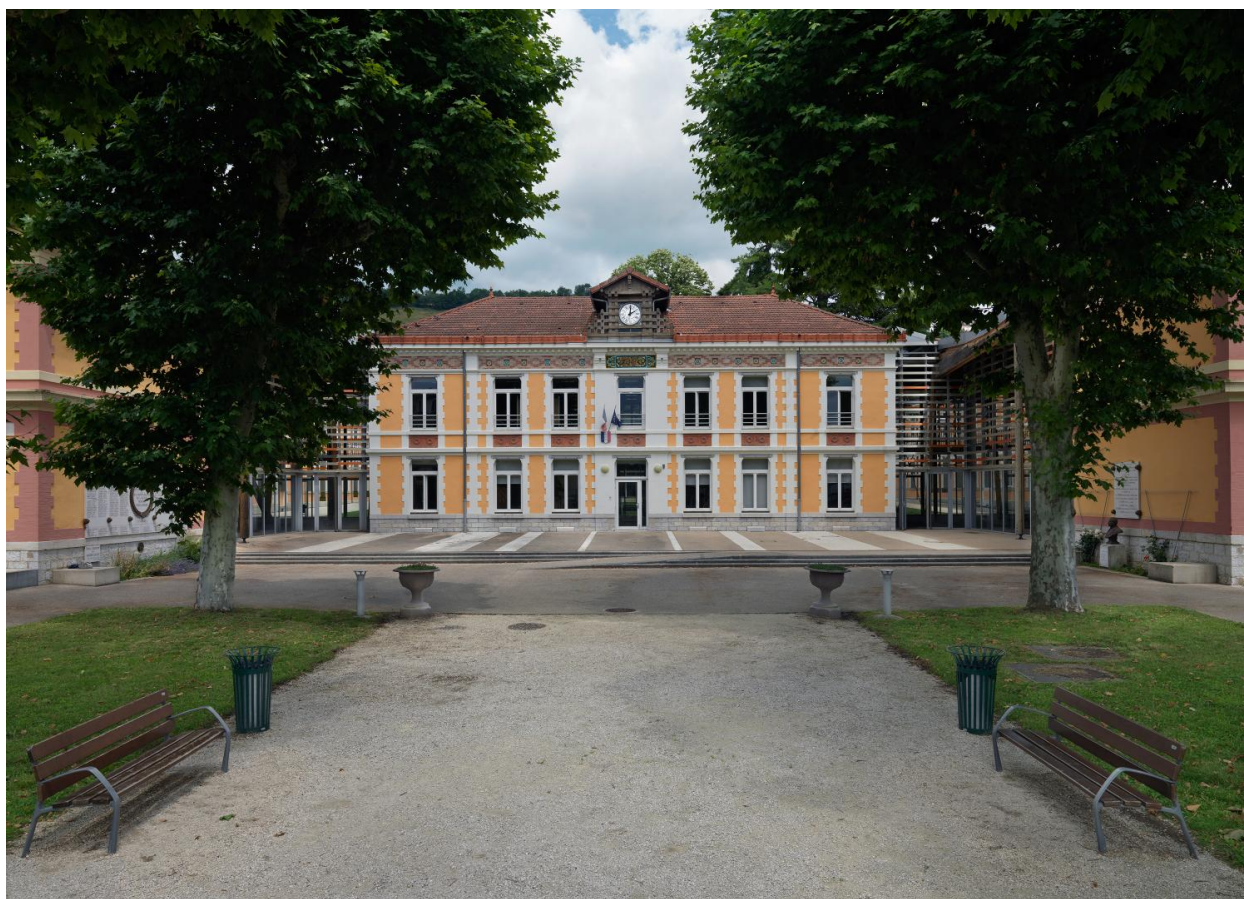
Bâtiment de l'administration
