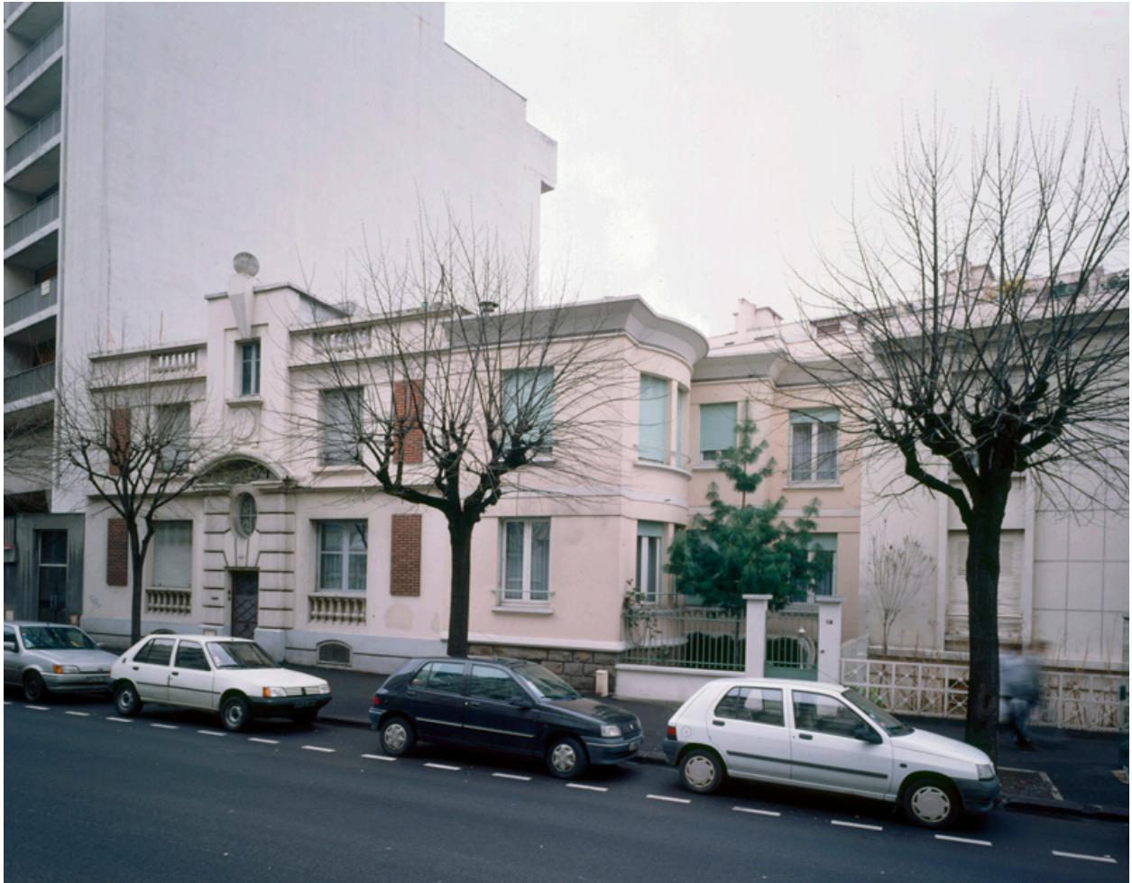
Façades sur le boulevard Cote-Blatin
