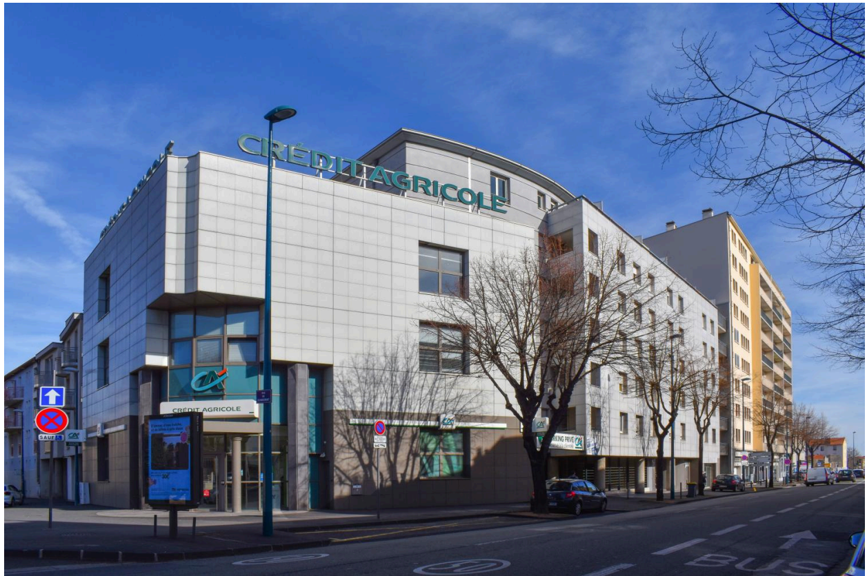
Anlge et du boulevard Cote-Blatin et de la rue de Romagnat
