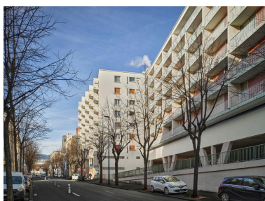
Elévation sur le boulevard Cote-Blatin Phot. Christian Parisey IVR84_20236300307NUC4A
