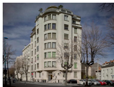
Façade d'angle rue Ledru et boulevard Cote-Blatin Phot. Christian Parisey IVR84_20236300314NUC4A
