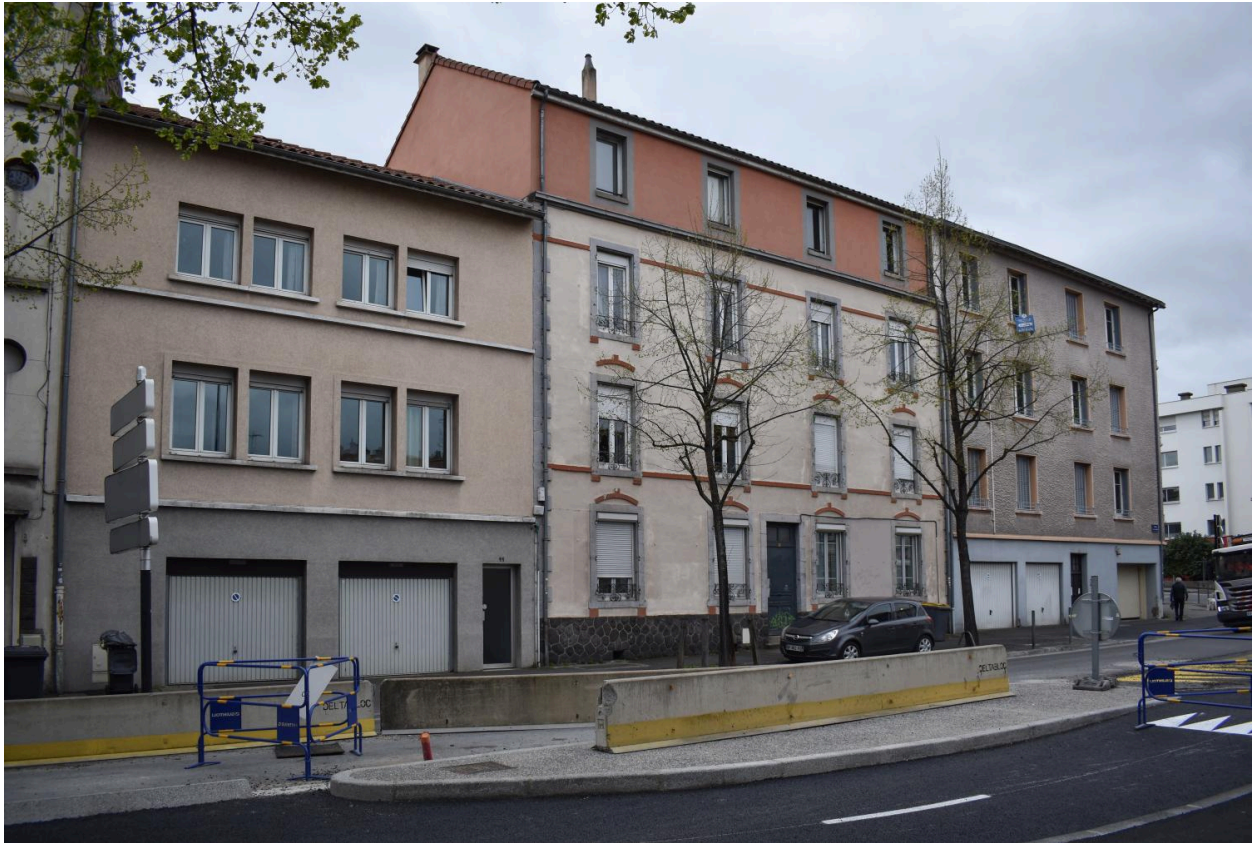
Façades sur le boulevard Cote-Blatin
