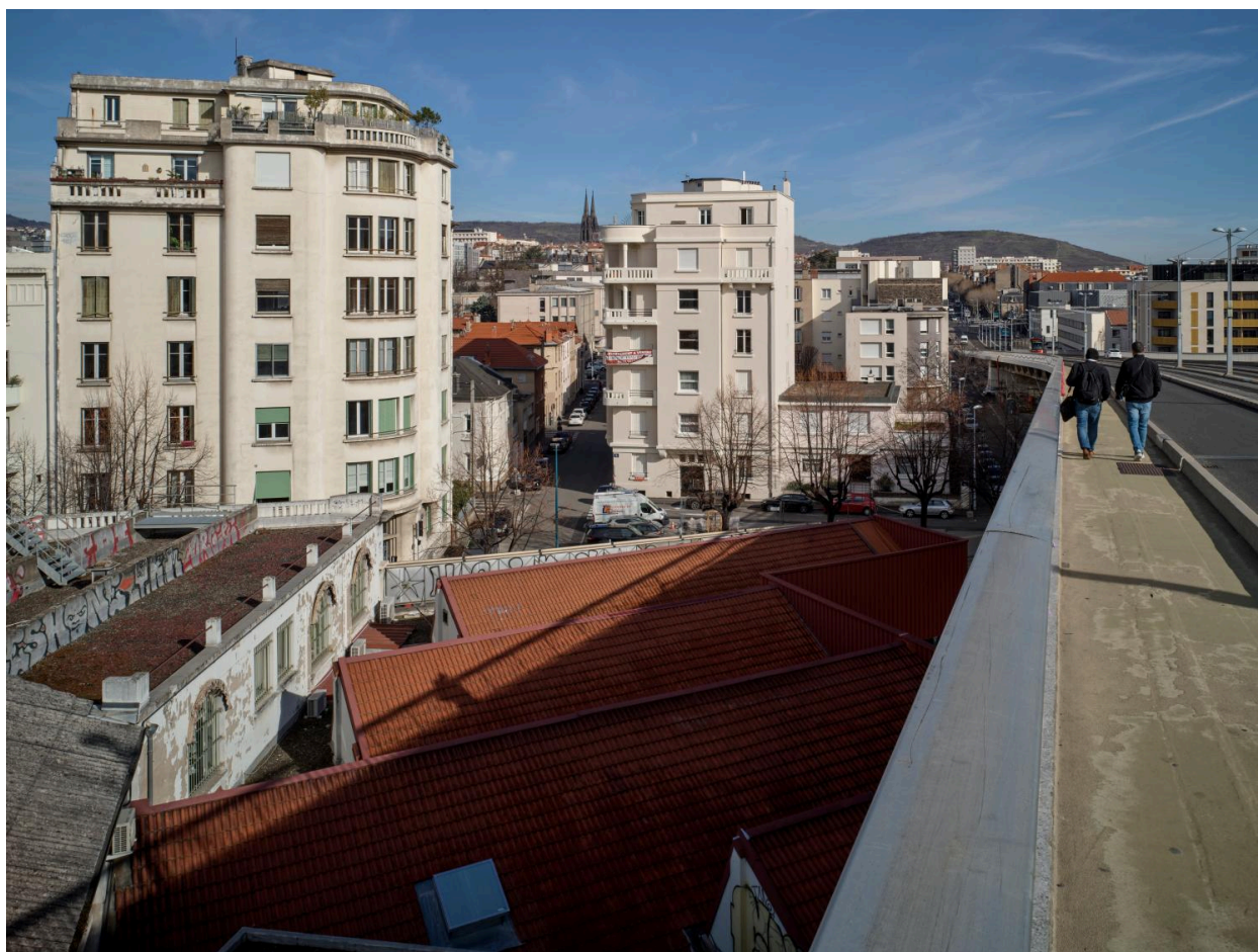
Débouché de la rue Ledru sur le boulevard Cote-Blatin, vue depuis le viaduc Saint-Jacques
