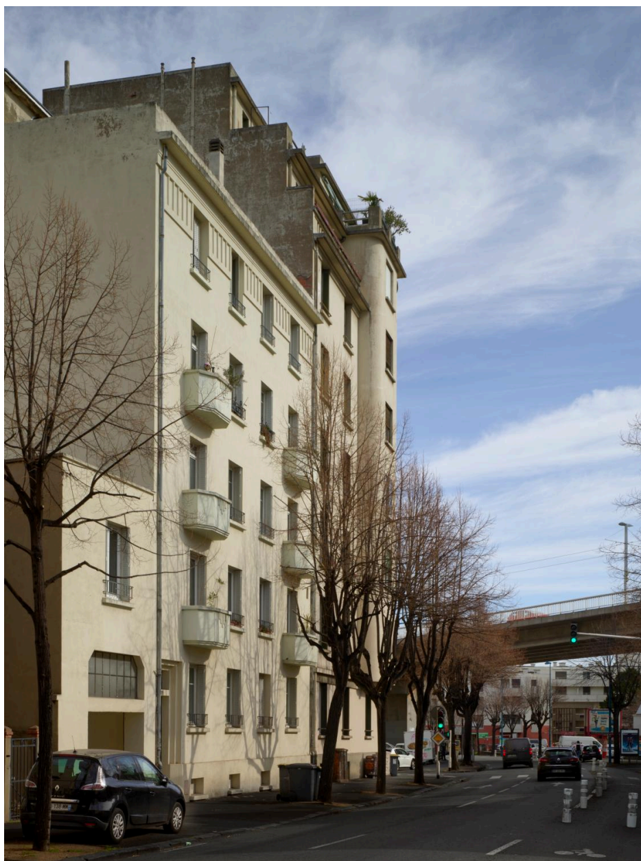
Façades sur le boulevard Cote-Blatin
