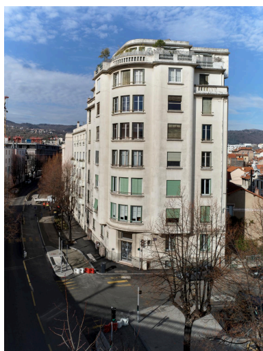
Façade d'angle rue Ledru et boulevard Cote-Blatin Phot. Christian Parisey IVR84_20246300377NUC4A
