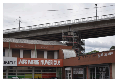
Viaduc Saint-Jacques vu depuis la zone industriel du boulevard Cote-Blatin Phot. Félicie Fougère IVR84_20246301482NUCA
