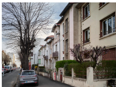
Vue urbaine Phot. Christian Parisey IVR84_20236300302NUC4A
