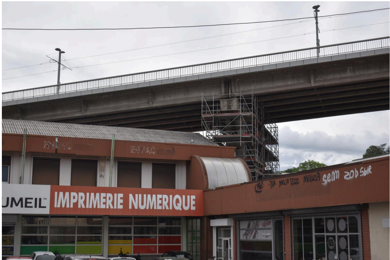
Viaduc Saint-Jacques vu depuis la zone industriel du boulevard Cote-Blatin
