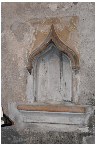
Lavabo à l'angle sud-est de la chapelle de la Baume. Phot. Maryse Durin-Tercelin IVR84_20250300129NUCA
