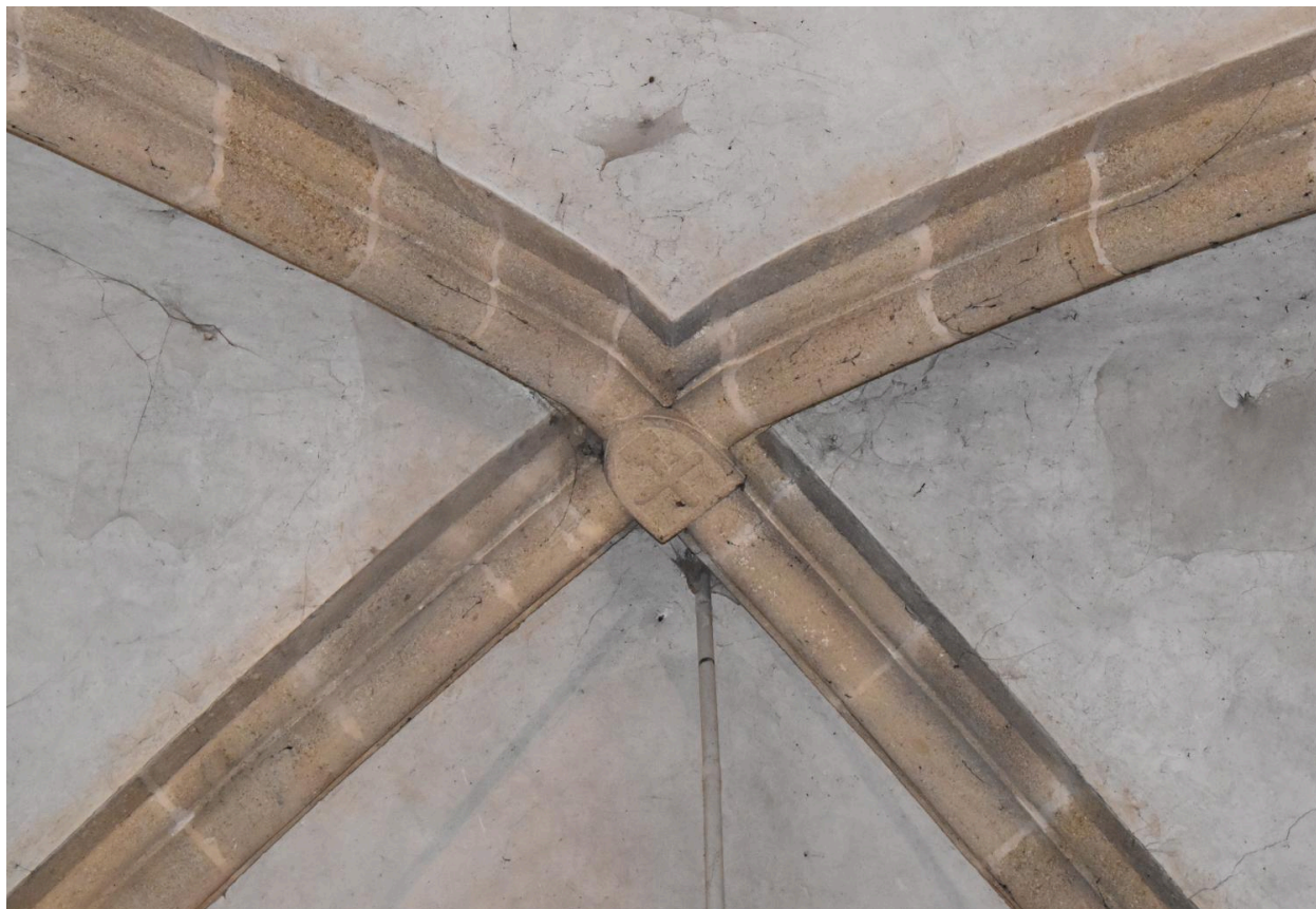
Détail de la croisée d'ogives à clef de voûte ornée d'une croix de la deuxième travée de la nef.
