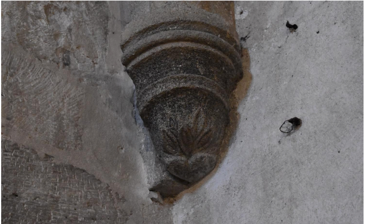
Culot à haut tailloir mouluré la retombée d'une ogive (angle sud-est de la seconde travée de la nef) sculpté de feuillages ou d'un cœur enflammé (?).
