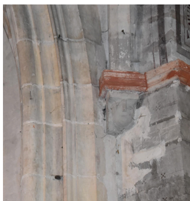
Détails de l'angle nord-est de la travée d'avant chœur : moulures de l'arc d'accès à la chapelle de la Baume, tête sculptée sur le culot de retombée d'ogive et pilastre d'accès à la travée droite du chœur. Phot. Maryse Durin-Tercelin IVR84_20250300128NUCA
