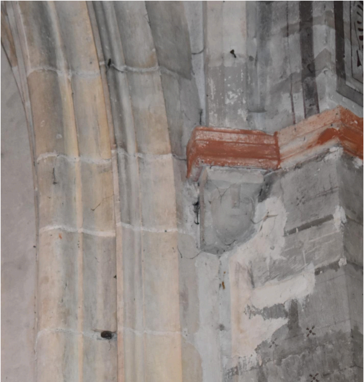
Détails de l'angle nord-est de la travée d'avant chœur : moulures de l'arc d'accès à la chapelle de la Beaume, tête sculptée sur le culot de retombée d'ogive et pilastre d'accès à la travée droite du chœur.
