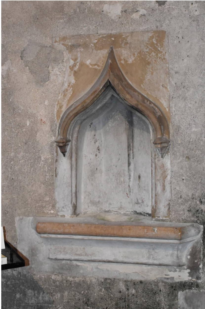
Lavabo à l'angle sud-est de la chapelle de la Baume.
