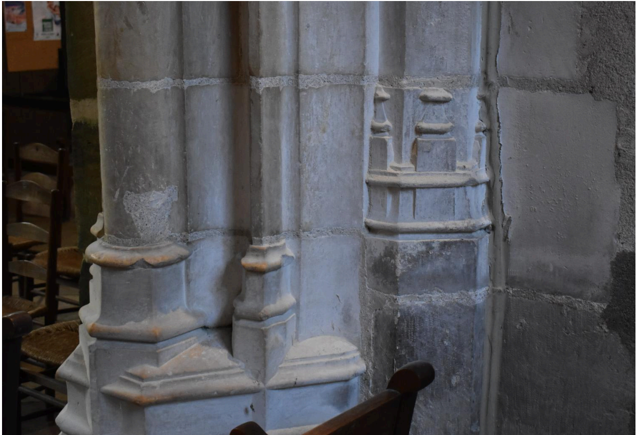
Détails des bases d'arcs et nervures à l'angle sud-ouest de la chapelle de la Beaume.
