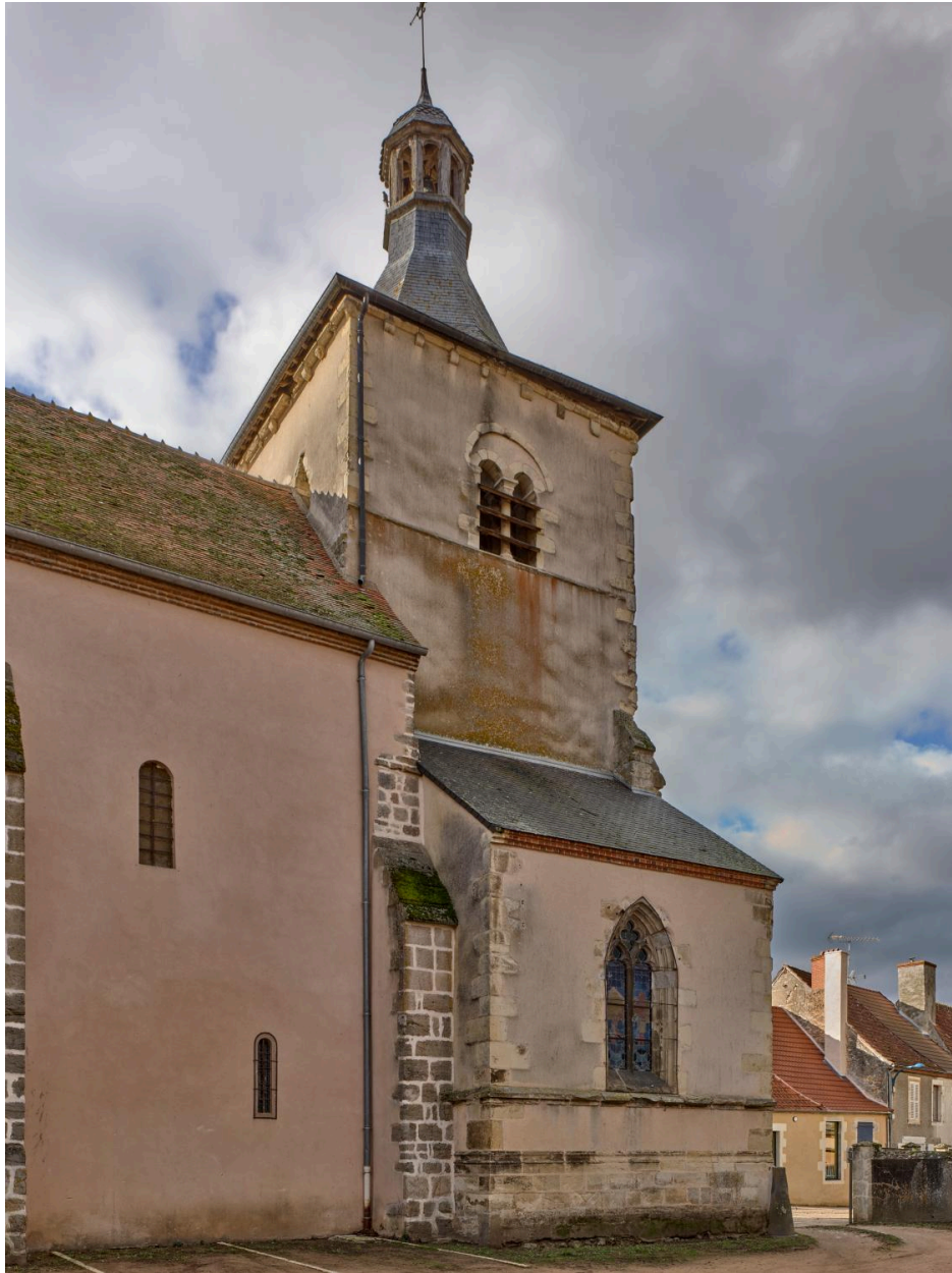
Partie du mur gouttereau de le nef, chapelle du 16e siècle adossée au clocher, sur le coté nord.
