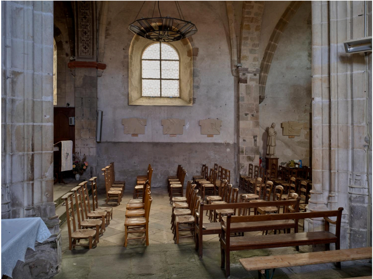
Vue intérieure du mur gouttereau nord depuis la chapelle de la Baume.
