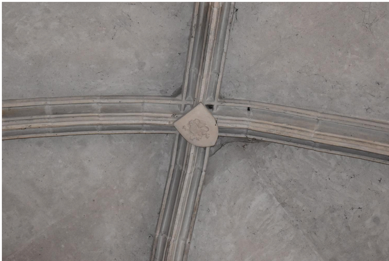
Détail de la voûte d'ogives à clef armoriée aux armes de La Baume Le Blanc.
