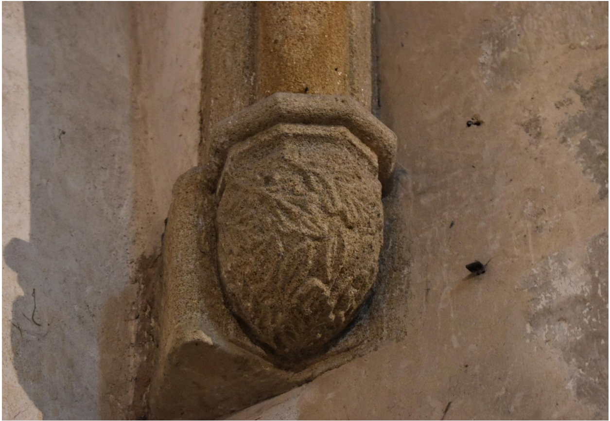
Culot au tailloir polygonal à la retombée d'une ogive (angle nord-est de la seconde travée de la nef) sculpté de feuilles de chêne.
