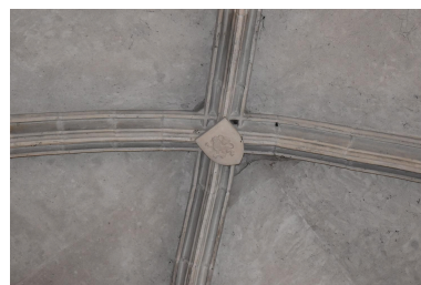
Détail de la voûte d'ogives à clef armoriée aux armes de La Baume Le Blanc. Phot. Maryse Durin-Tercelin IVR84_20250300133NUCA
