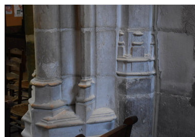
Détails des bases d'arcs et nervures à l'angle sud-ouest de la chapelle de la Baume. Phot. Maryse Durin-Tercelin IVR84_20250300130NUCA
