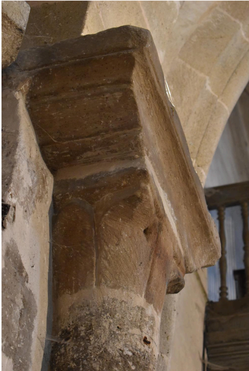
Chapiteau roman sculpté de feuilles d'eau à la retombée sud de l'arc doubleau brisé limitant la première travée et la seconde travée de la nef, vu de trois quarts.
