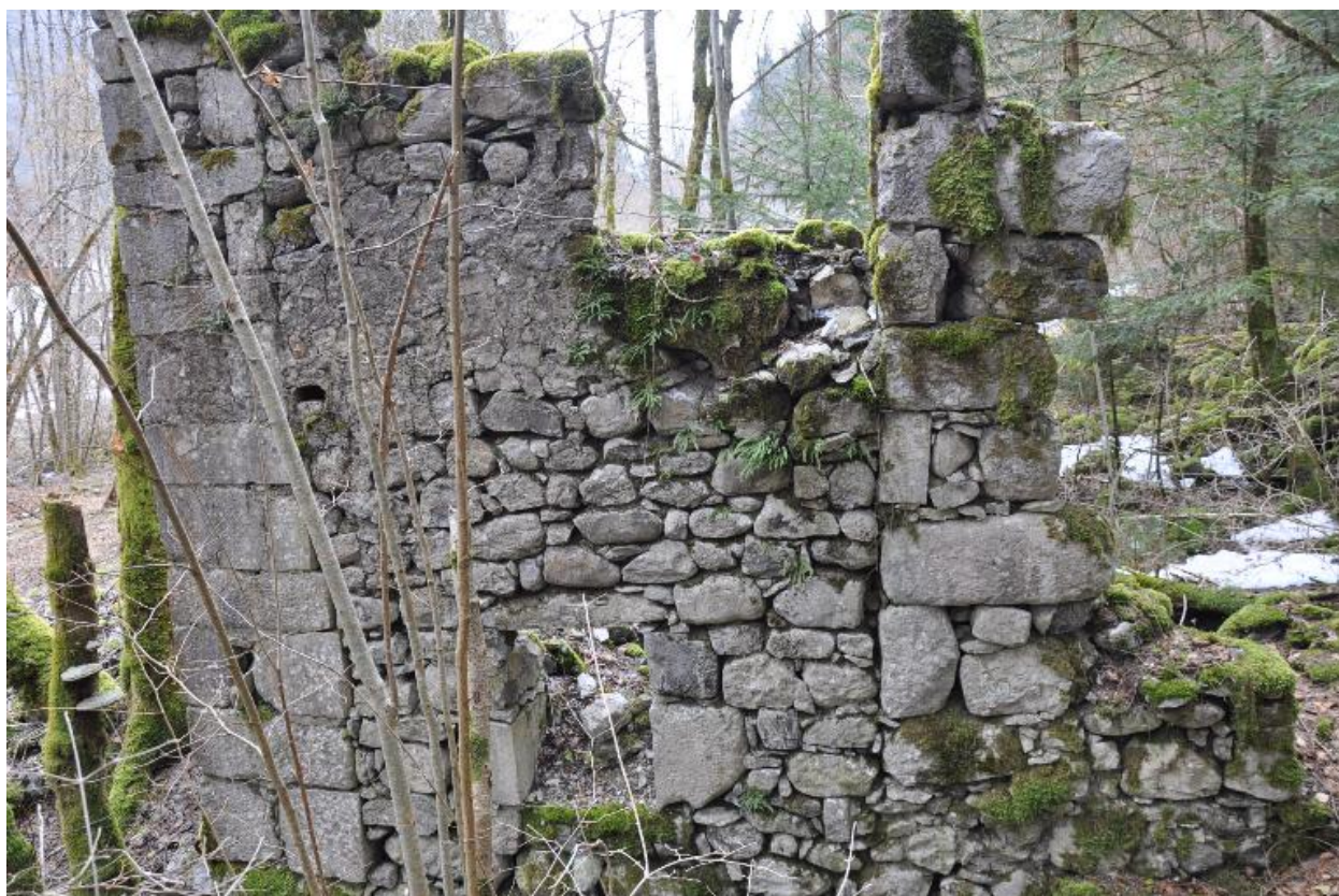
Elevation du mur nord-ouest du moulin.
