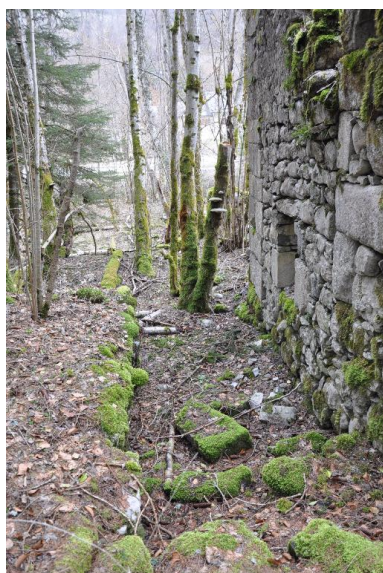
Vue de l'emplacement de la roue depuis le bief d'aménée. Phot. Clara Bérelle IVR82_20137301616NUCA
