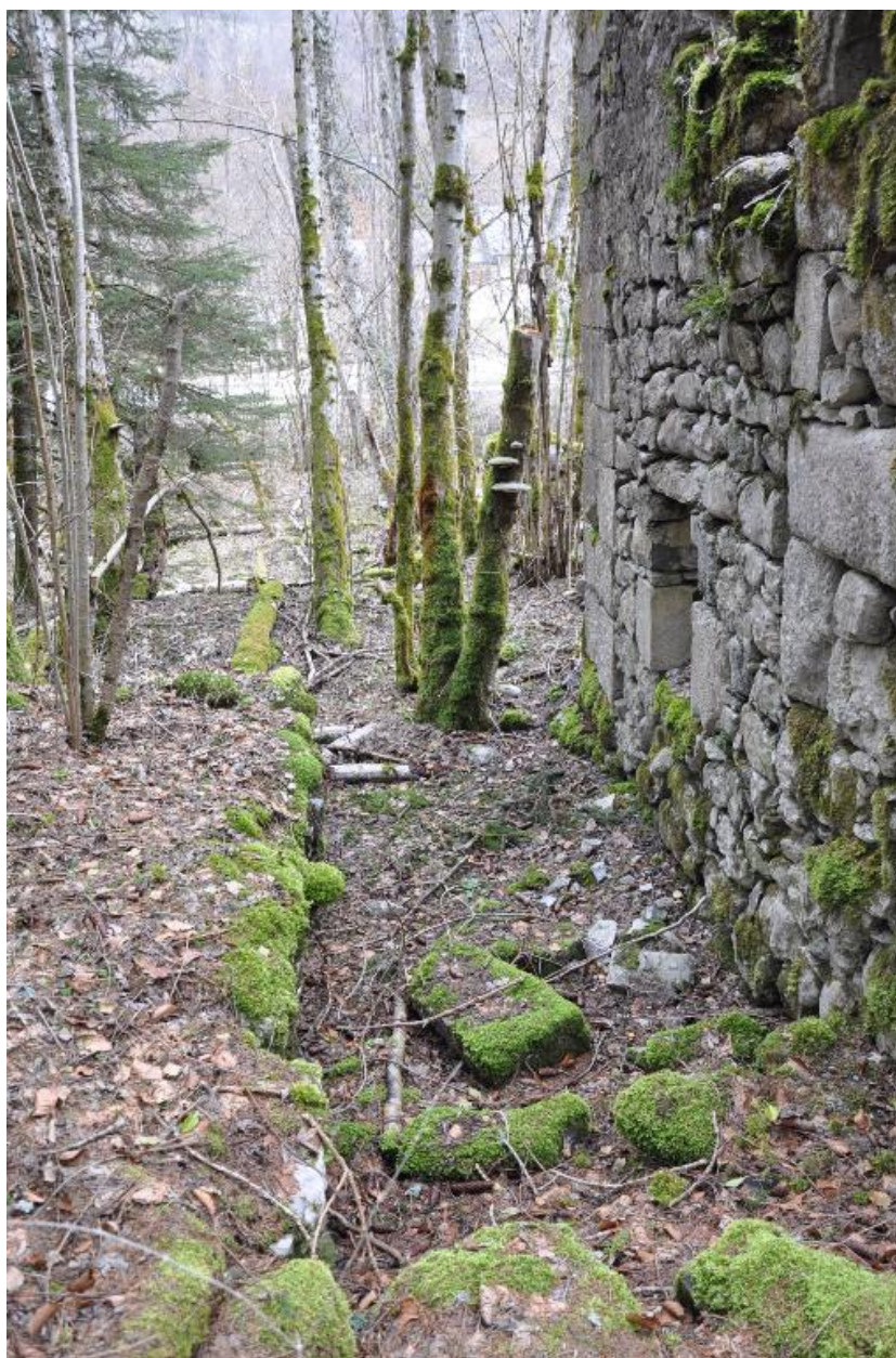
Vue de l'emplacement de la roue depuis le bief d'amenée.
