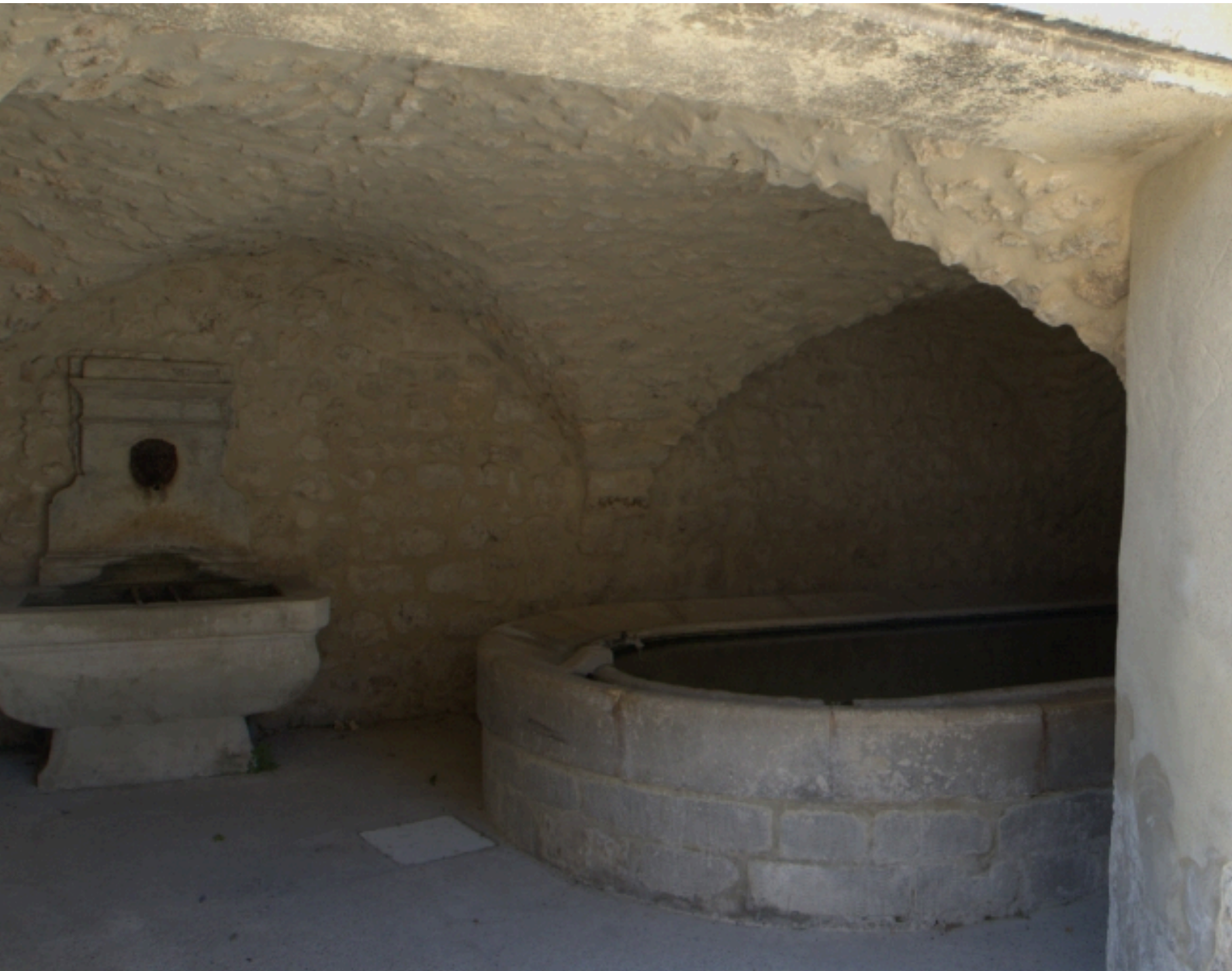
Le lavoir et la fontaine, vue d'ensemble.
