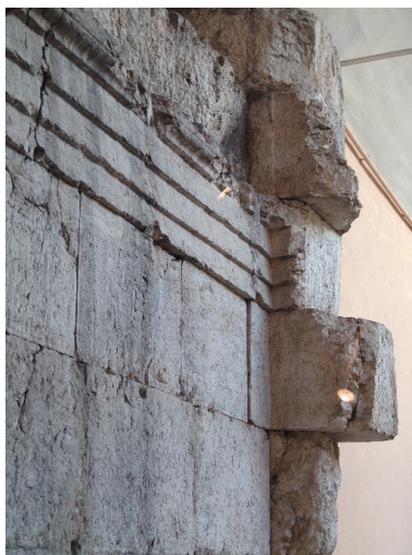
Mur sud visible à l'intérieur de l'hôtel de ville Phot. François Fouger IVR82_20067300369NUCA
