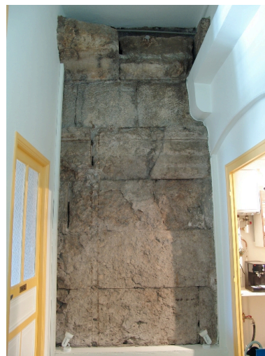
Mur sud visible au 1er étage de l'hôtel de ville Phot. François Fouger IVR82_20067300374NUCA
