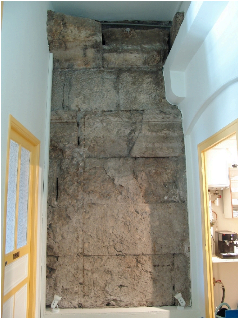
Mur sud visible au 1er étage de l'hôtel de ville
