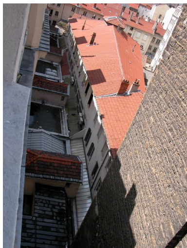
Elévation postérieure depuis le 4 avenue Jean-Jaurès Phot. Maryannick Chalabi IVR82_20046904537NUCA
