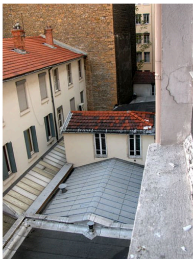
Elévation postérieure depuis le 8 avenue Jean-Jaurès Phot. Maryannick Chalabi IVR82_20046904671NUCA
