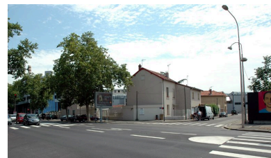
Vue de l'îlot 43 à 49 rue Edouard-Nieuport, 56 et 58 avenue Jean-Mermoz depuis le nord ouest Phot. Catherine Guégan IVR82_20076902213NUCA
