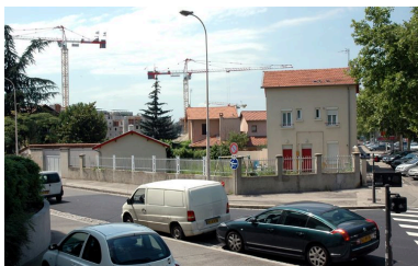
Vue de situation Phot. Catherine Guégan IVR82_20076902216NUCA
