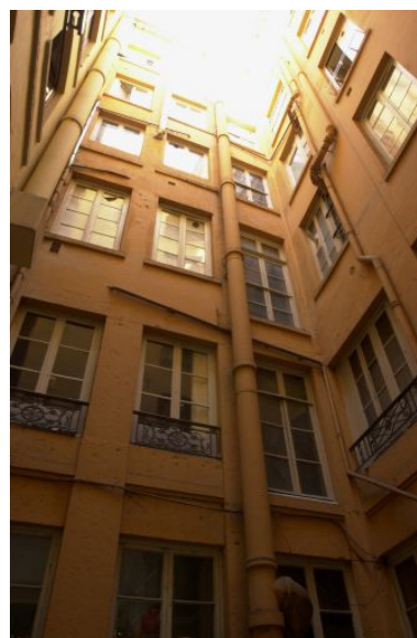
Vue générale des façades sur cour Phot. Phot. Inv. D. Chevallier IVR82_20046900424NUCA
