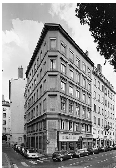
Vue générale des façades Phot. Didier Gourbin IVR82_20046905927V
