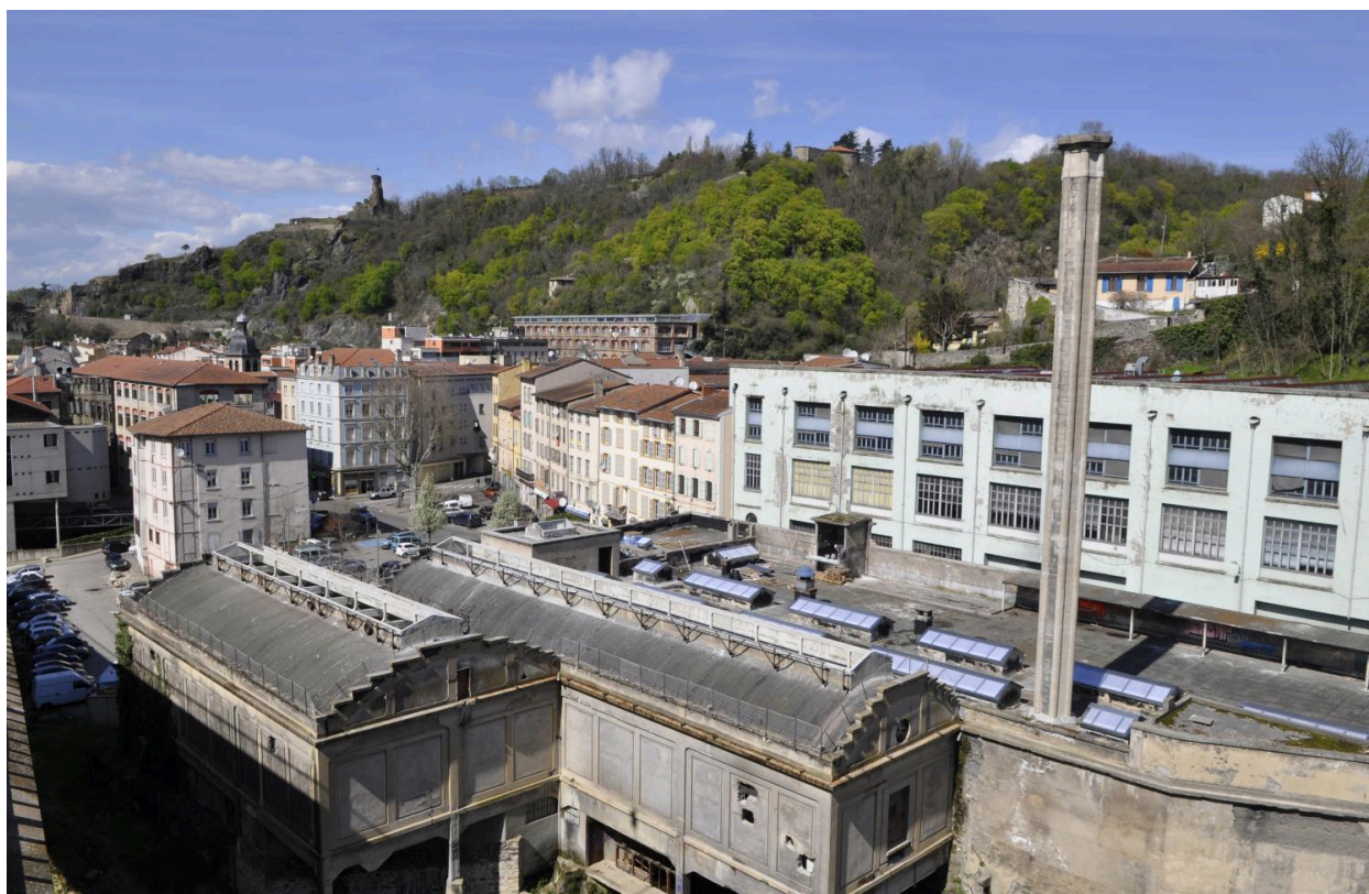
Vue d'ensemble avant travaux
