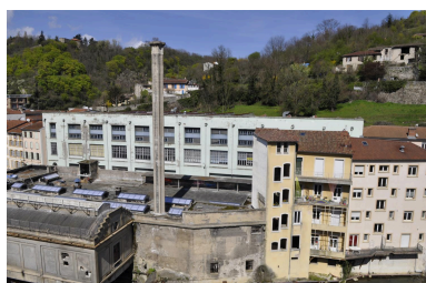
Vue d'ensemble avant travaux Phot. Nadine Halitim-Dubois IVR84_20203800500NUCA
