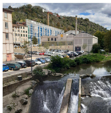
Vue d'ensemble extérieur après reconversion du site Phot. Nadine Halitim-Dubois IVR84_20203800496NUCA
