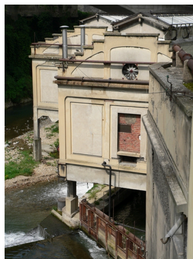
Façades est Phot. Isabelle Dupuis IVR82_20093800531NUCA
