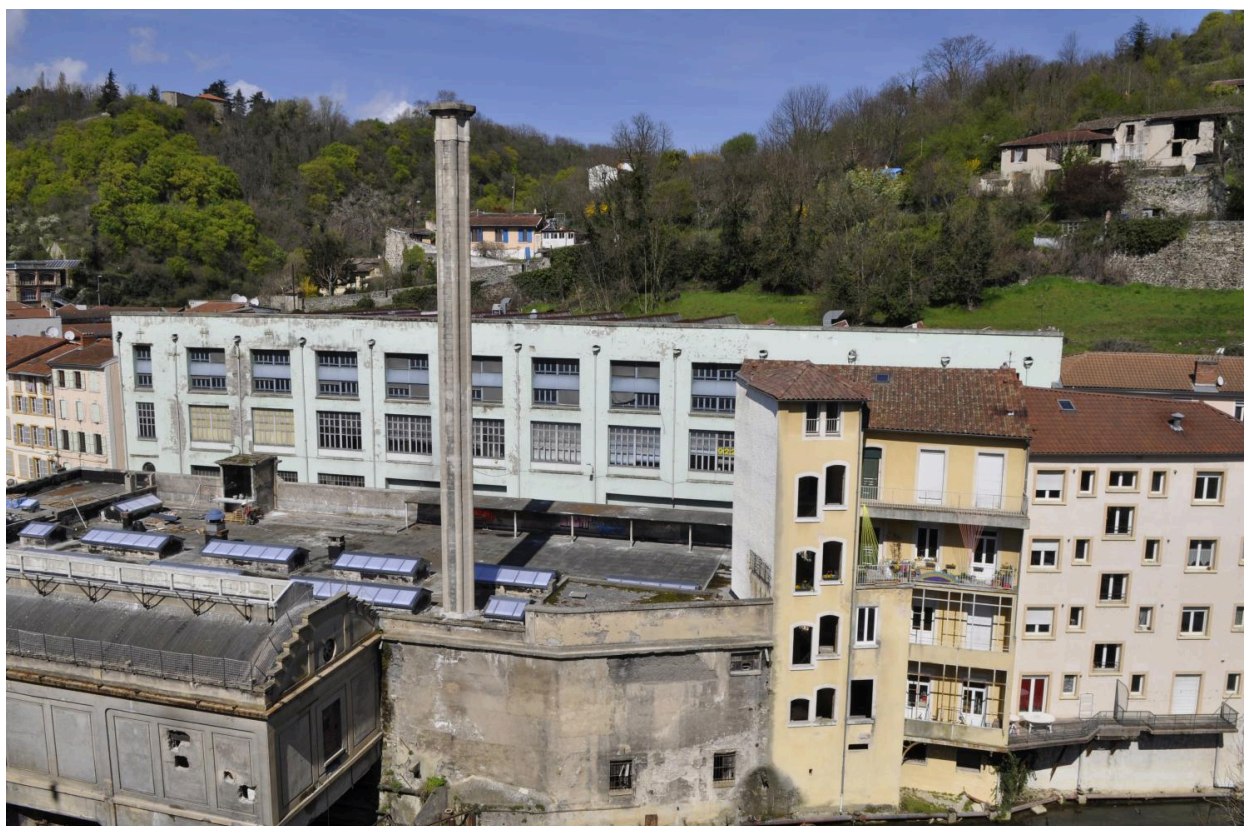
Vue d'ensemble avant travaux
