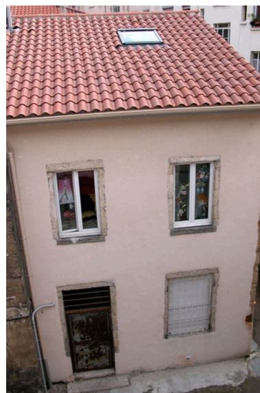
Elévation sud sur cour Phot. N. Giroud IVR82_20046904138NUCA
