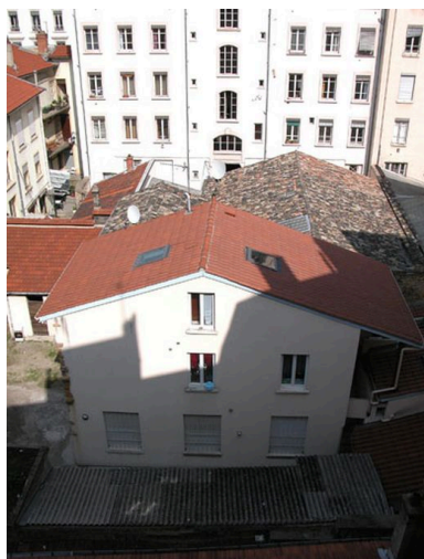
Elévation est depuis un immeuble avenue Jean-Jaurès Phot. Maryannick Chalabi IVR82_20046904539NUCA
