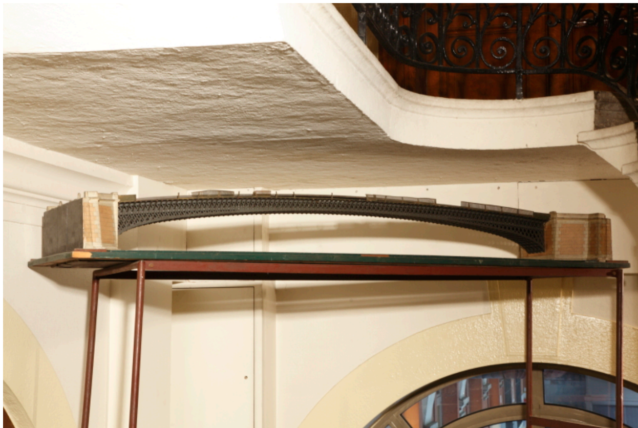
Le pont métallique.
