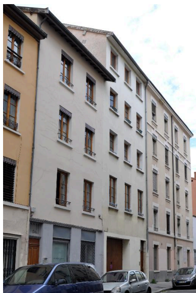
Vue d'ensemble, élévation sur rue Phot. Magali Delavenne IVR84_20176901047NUCA
