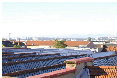
Vue générale des toitures Phot. Nadine Halitim-Dubois IVR82_20106900508NUCA
