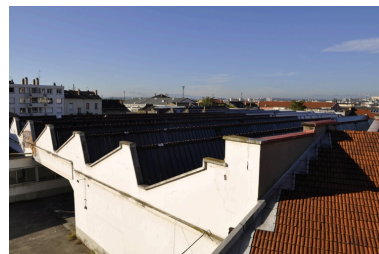
Vue des sheds Phot. Nadine Halitim-Dubois IVR82_20106900507NUCA
