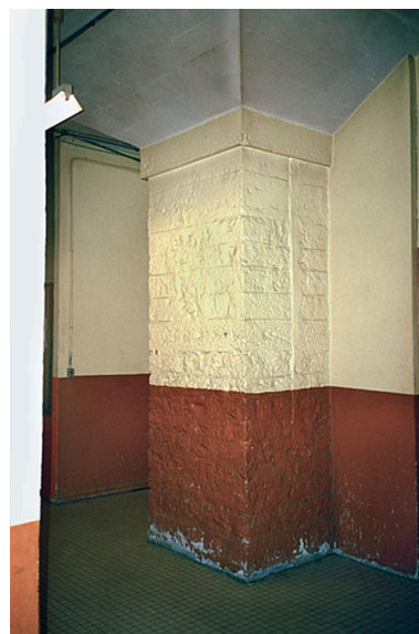
Pilier rez-de-chaussée Phot. Nadine Halitim-Dubois IVR82_20046902641ZA
