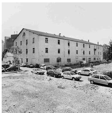
Vue d'ensemble ouest Phot. Didier Gourbin IVR82_20046902636X
