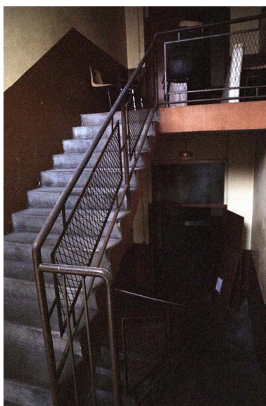
Escalier latéral est Phot. Nadine Halitim-Dubois IVR82_20076900787NUCA
