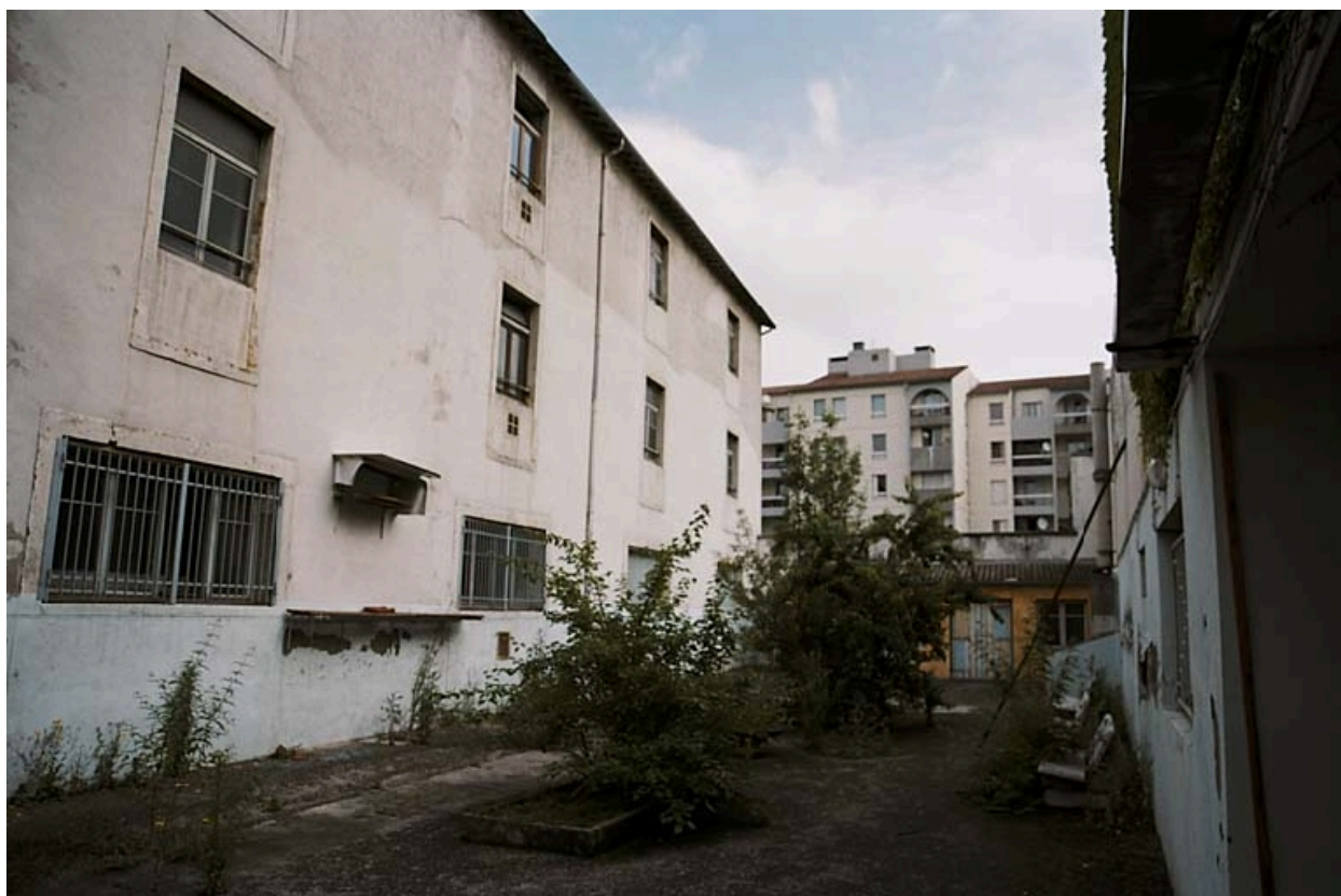
Vue de la cour intérieure
