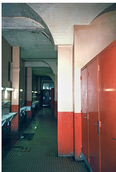
Pilier 1er étage Phot. Nadine Halitim-Dubois IVR82_20046902643ZA
