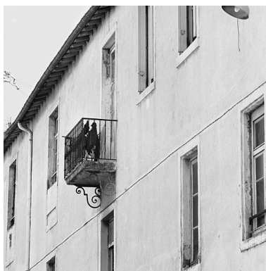
Balcon façade ouest Phot. Didier Gourbin IVR82_20046902637X
