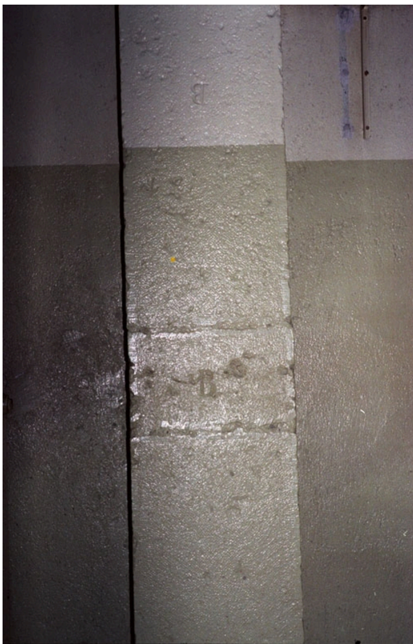
Marque de tacheron sur le pilier deuxième niveau
