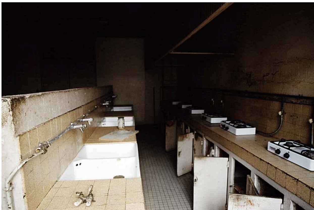
Cuisine collective premier étage
