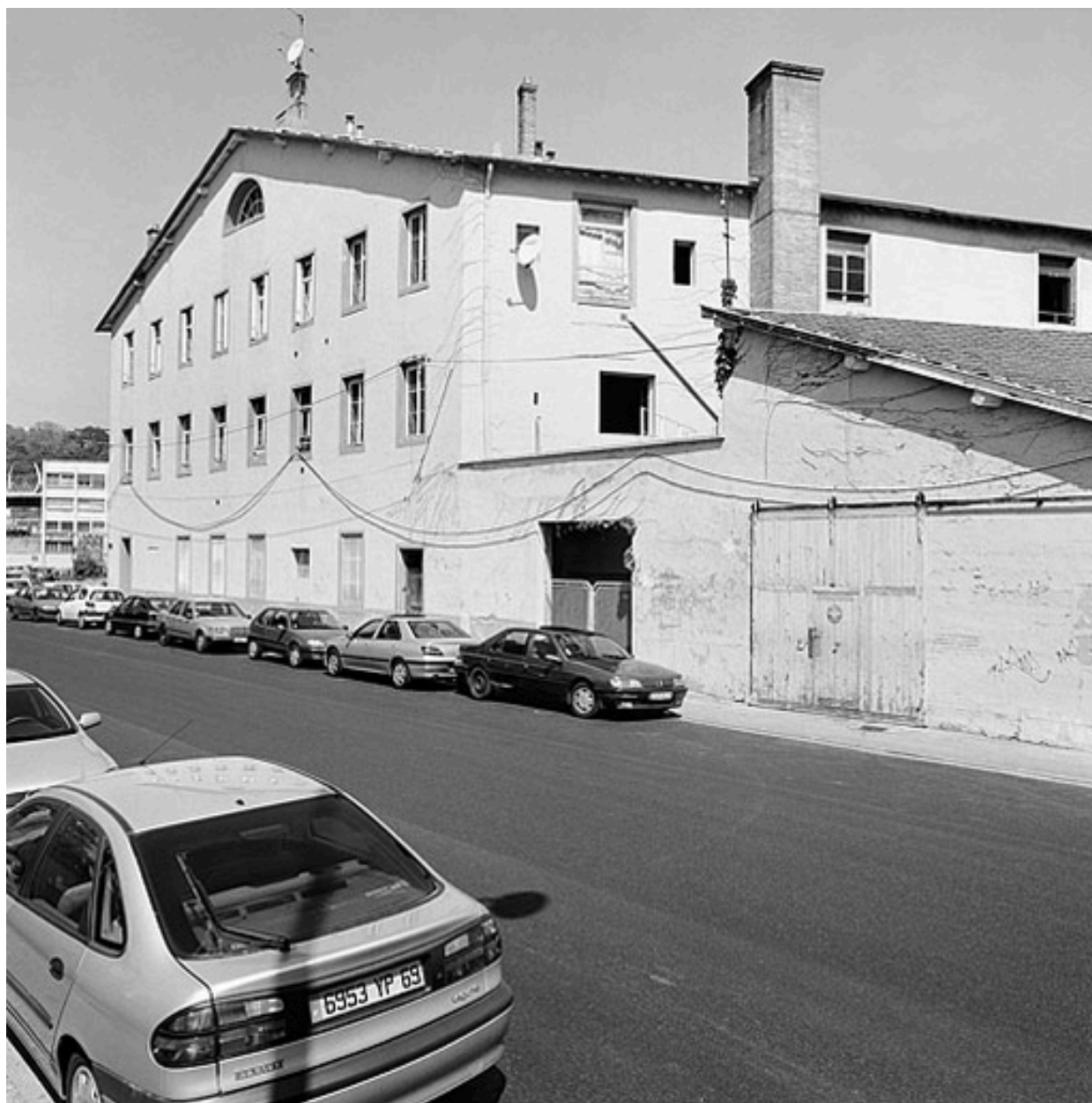
Vue façade sud
