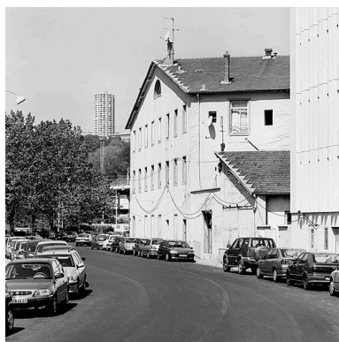
Vue est Phot. Didier Gourbin IVR82_20046902639X
