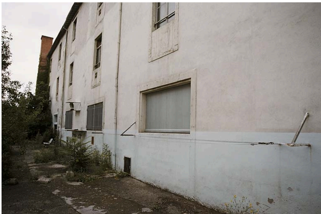
Façade est du bâtiment principal
