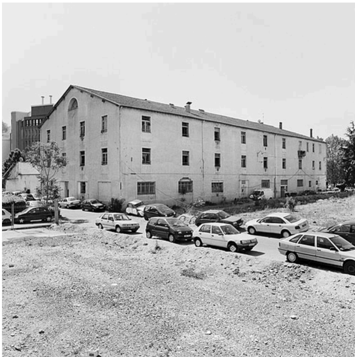
Vue d'ensemble ouest
