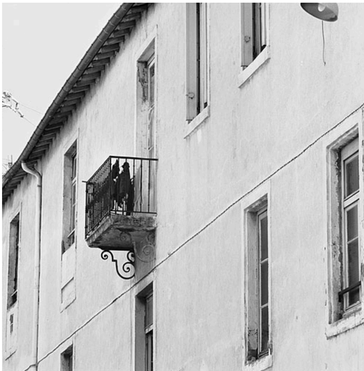
Balcon façade ouest
