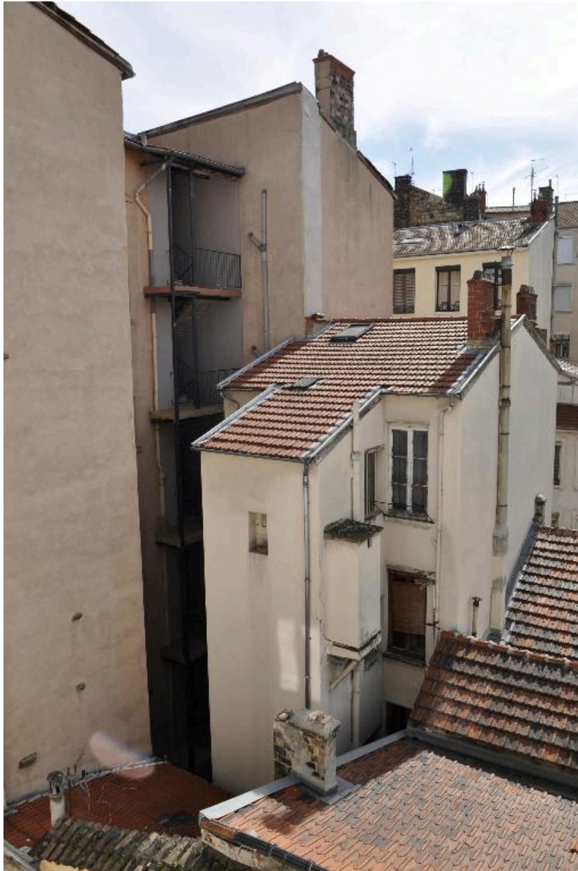
Vue générale, élévation sur cour
