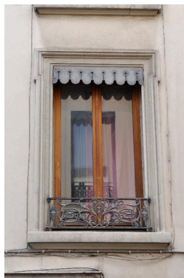
Elévation sur rue, détail d'une baie du premier étage Phot. Catherine Guégan IVR84_20176901090NUCA
