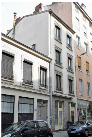
Vue générale, élévation sur rue Phot. Catherine Guégan IVR84_20176901088NUCA
