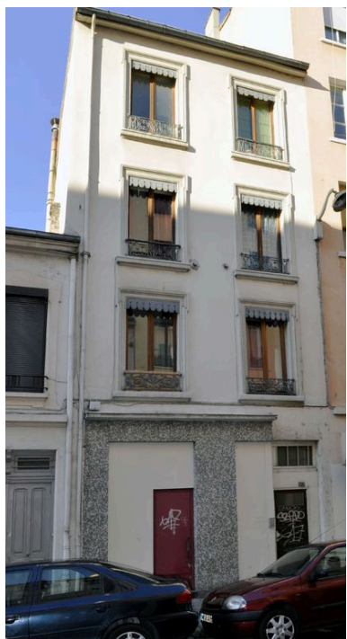
Elévation sur rue, vue prise en 2010 Phot. Julien Defillon IVR82_20106900807NUCA
