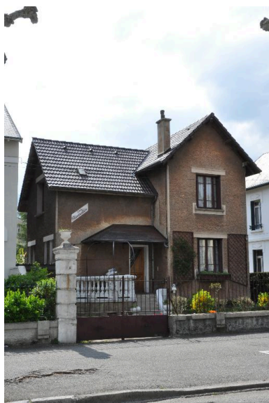
Vue d'ensemble Phot. Denys Harreau IVR82_20137300100NUCA
