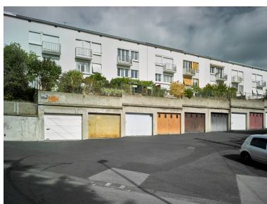
Habitations en bande, avec jardins sur garages semi- enterrés, allée Rémy-Jamet. Phot. Christian Parisey IVR84_20196300353NUC4A
