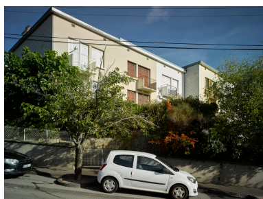
Habitations en bande (années 1959-1960), rue de Trémonteix. Phot. Christian Parisey IVR84_20196300352NUC4A
