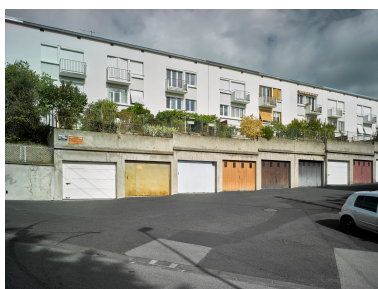
Habitations en bande, avec jardins sur garages semi- enterrés, allée Rémy-Jamet. Phot. Christian Parisey IVR84_20196300353NUC4A
