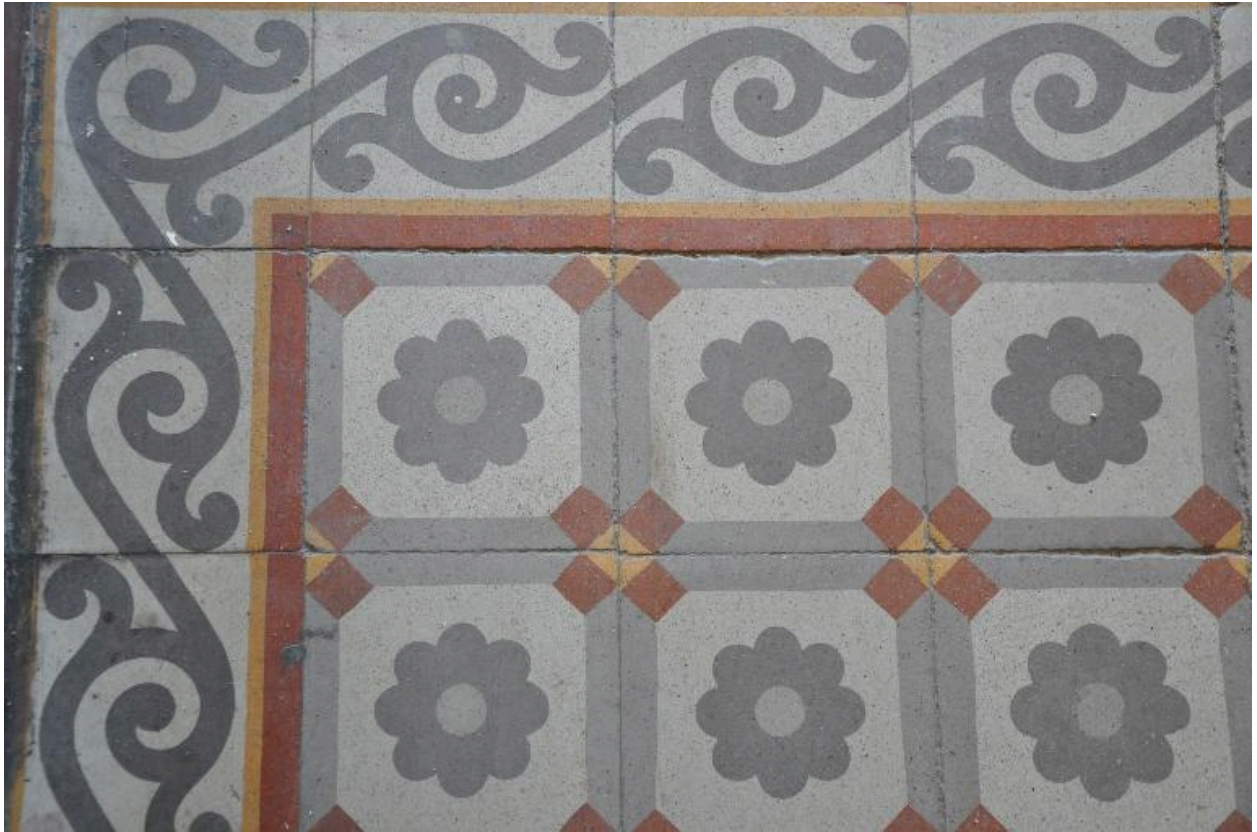
Sol en carreau de ciment
