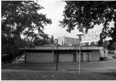
Elévation postérieure Sud-Ouest Phot. Catherine Guégan IVR82_20096900763NUC
