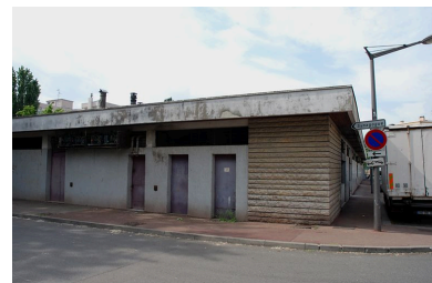
Elévation postérieure Sud-Ouest Phot. Catherine Guégan IVR82_20096900762NUCA
