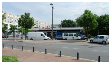
Elévation antérieure Nord-Est Phot. Catherine Guégan IVR82_20096900765NUCA
