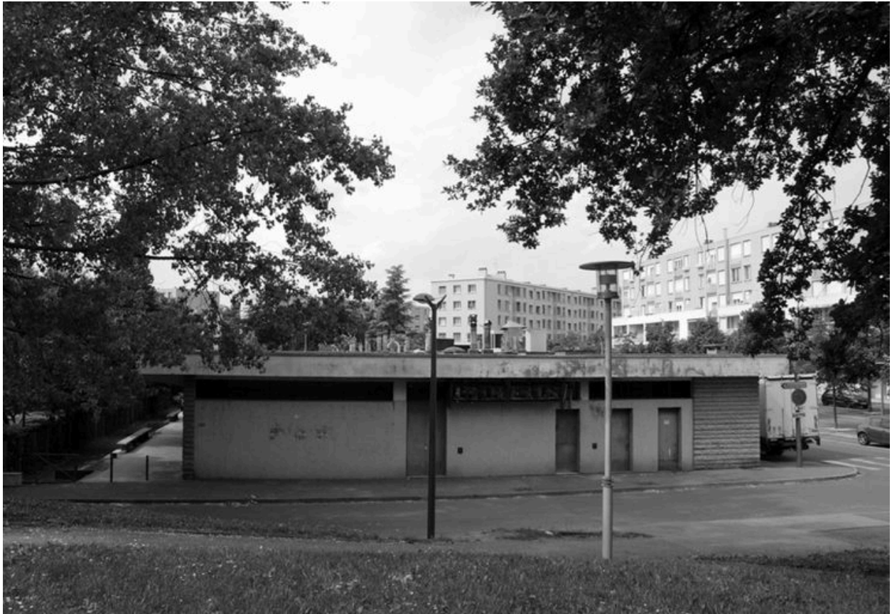
Elévation postérieure Sud-Ouest
