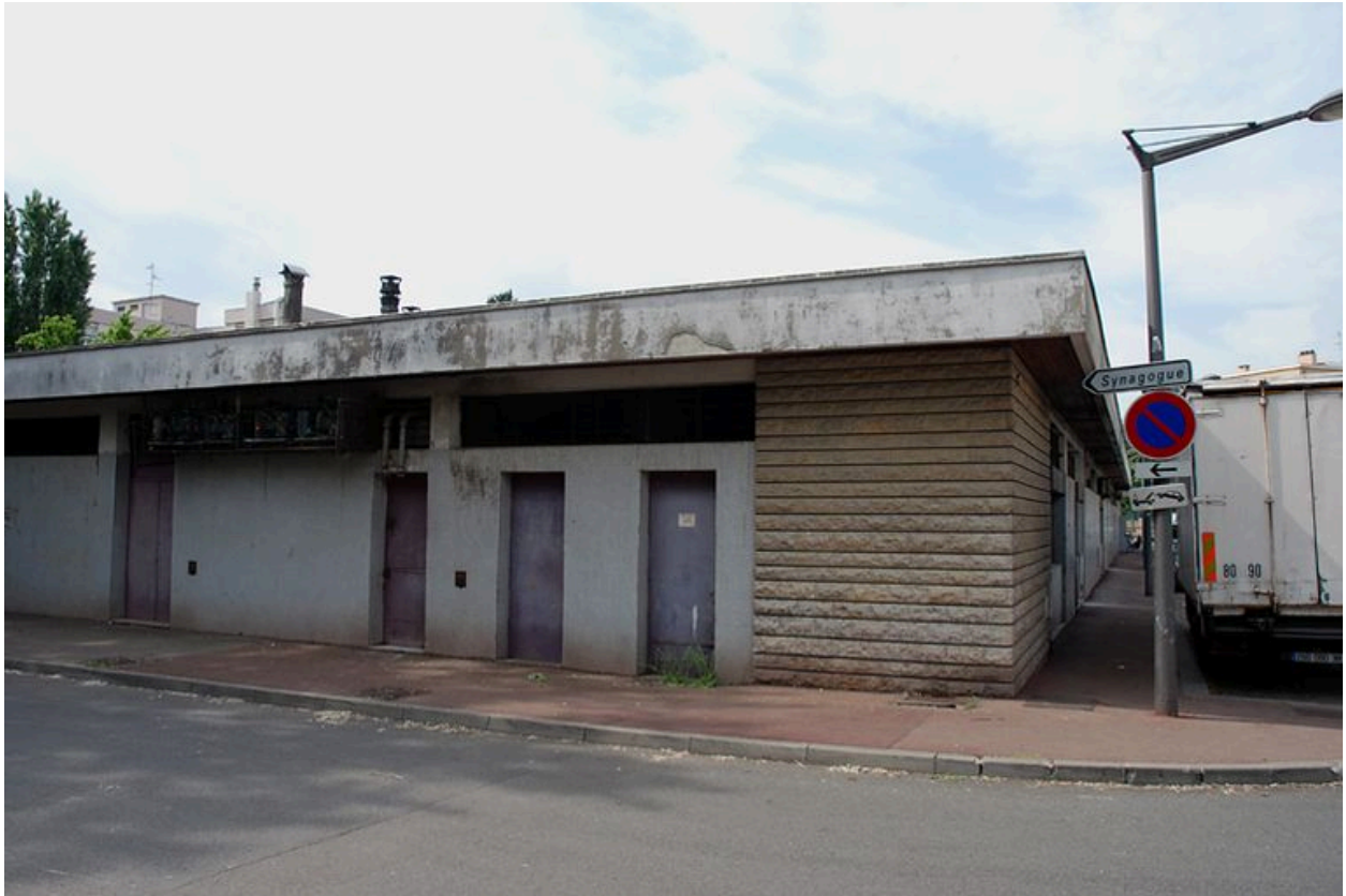
Elévation postérieure Sud-Ouest
