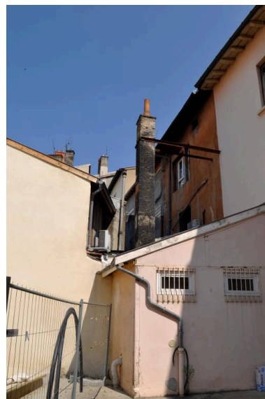
Vue des bâtiments sur cour, au premier plan le four de boulanger construit en 1902 Phot. Magali Delavenne IVR84_20186900961NUCA
