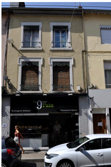
Vue rapprochée du n°10 Phot. Magali Delavenne IVR84_20186900958NUCA
