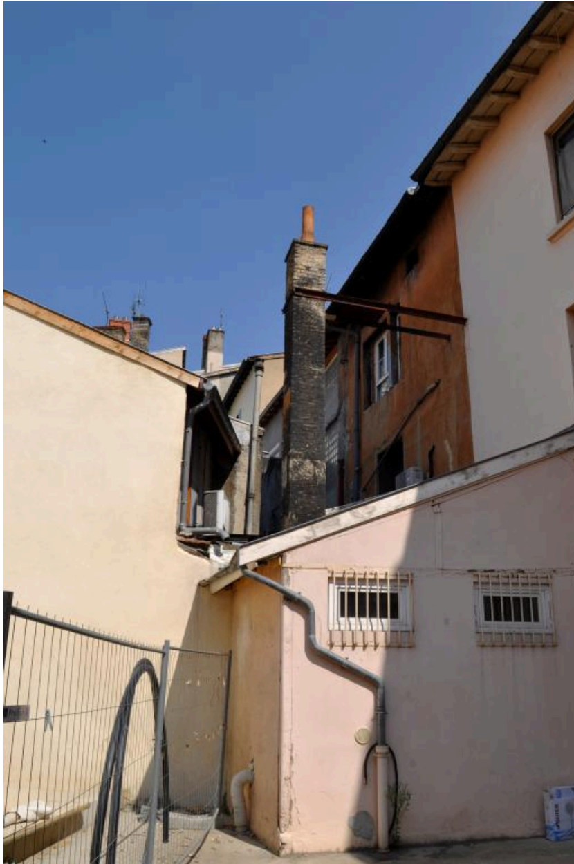
Vue des bâtiments sur cour, au premier plan le four de boulanger construit en 1902
