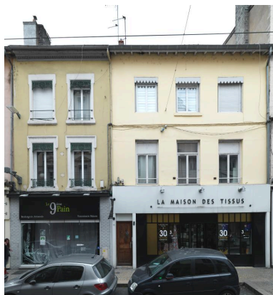
Vue de l'ensemble formé par les n°8 et 10 grande rue de Vaise, maisons jumelées Phot. Franck Trabouillet IVR84_20196900386NUCA
