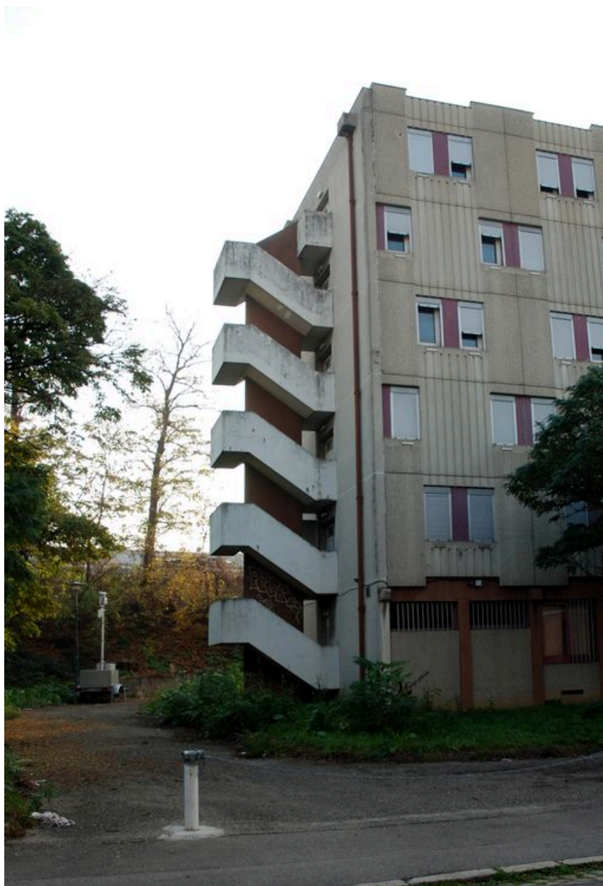
Vue d'un des deux escaliers de secours extérieurs.
