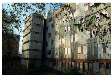
Vue du revers avec le bloc sanitaire. Phot. Catherine Guégan IVR82_20116902609NUCA
