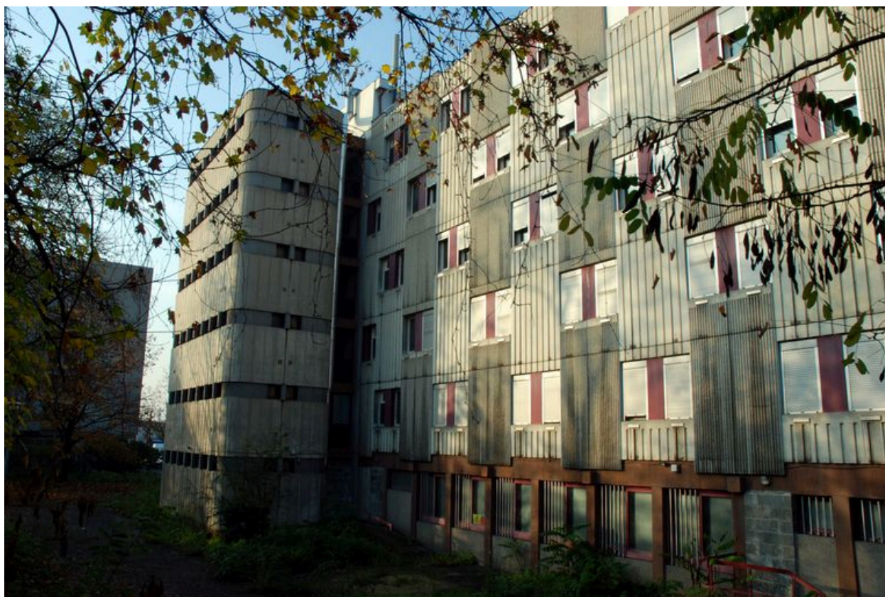
Vue du revers avec le bloc sanitaire.
