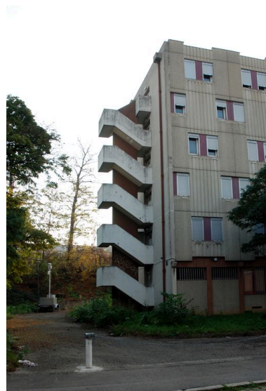
Vue d'un des deux escaliers de secours extérieurs. Phot. Catherine Guégan IVR82_20116902608NUCA
