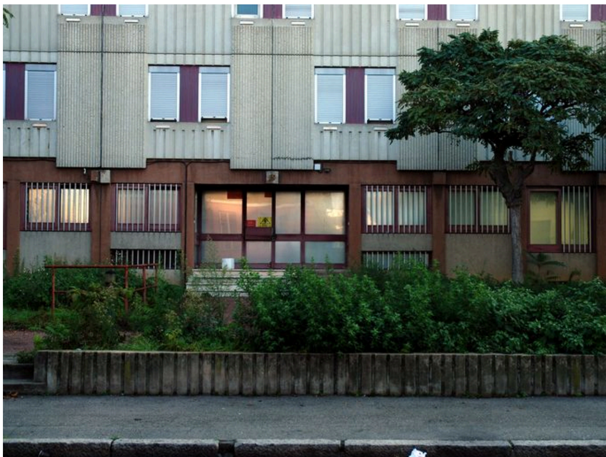
Détail de l'entrée.
