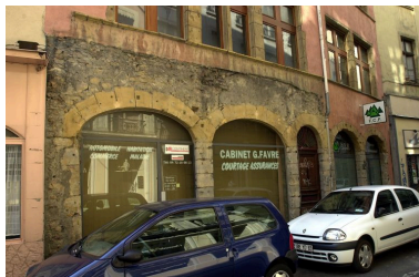
Façade, détail du rez-de-chaussée Phot. Bernard Ducouret IVR82_20046900027NUCA
