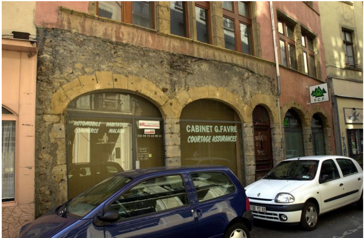
Façade, détail du rez-de-chaussée
