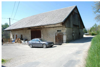
Vue d'ensemble de la ferme. Phot. Thierry Monnet IVR84_20167302197NUCA
