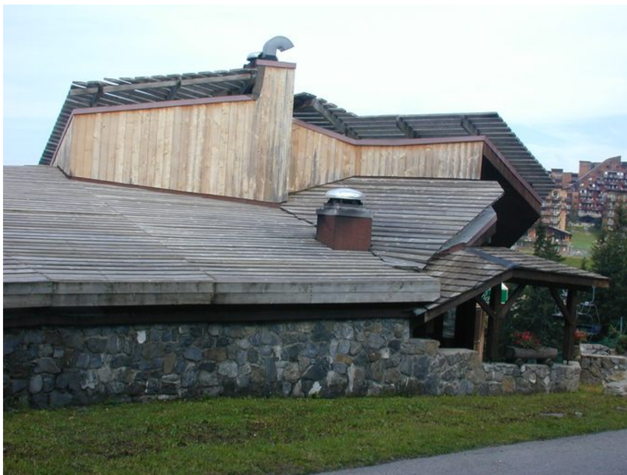
Elévation nord-ouest, entrée amont des logements
