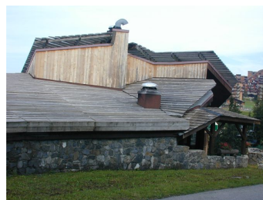
Elévation nord-ouest, entrée amont des logements Phot. Jean-François Lyon-Caen, Phot. C. Salomon-Pelen IVR82_20087400977NUCA
