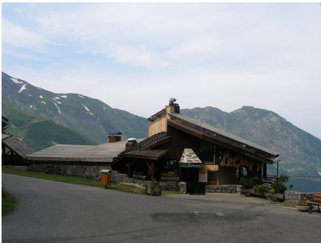
Vue générale depuis le nord-est, entrée amont du bar-restaurant
