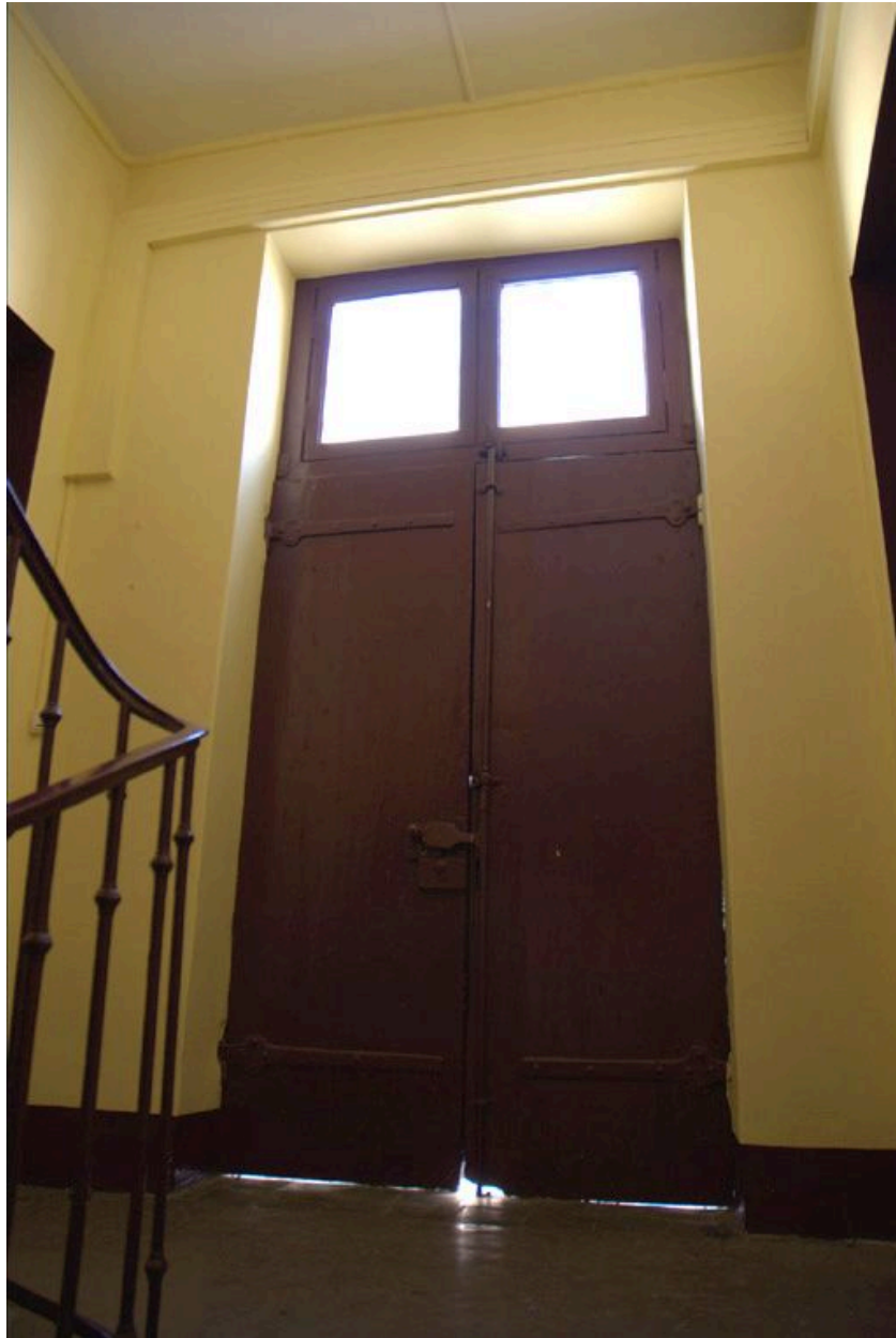
Porte d'accès à la terrasse, 2e palier de l'escalier
