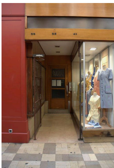
Vue de l'entrée de l'immeuble, en retrait du passage Phot. Catherine Guégan IVR82_20096900556NUCA
