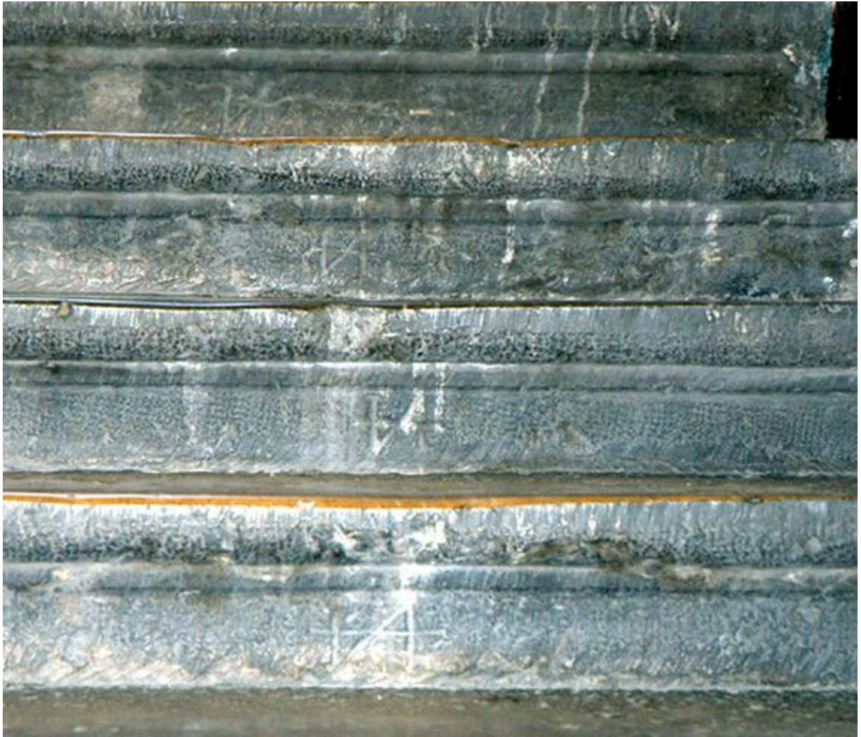
Escalier, marques de tâcheron
