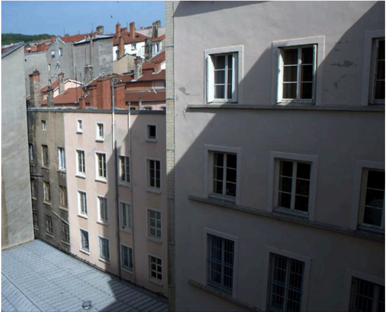
Élévation postérieure, vue partielle depuis le sud-est
