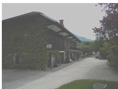
Vue générale de la façade principale. Phot. Jérôme Daviet IVR82_20117400738NUCA
