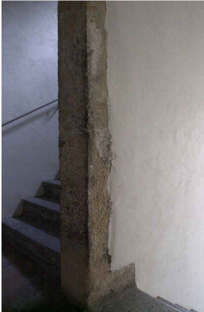
Le mur noyau au niveau du 1er palier
