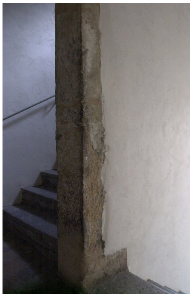
Le mur noyau au niveau du 1er palier Phot. Maryannick Chalabi IVR82_20096901047NUCA
