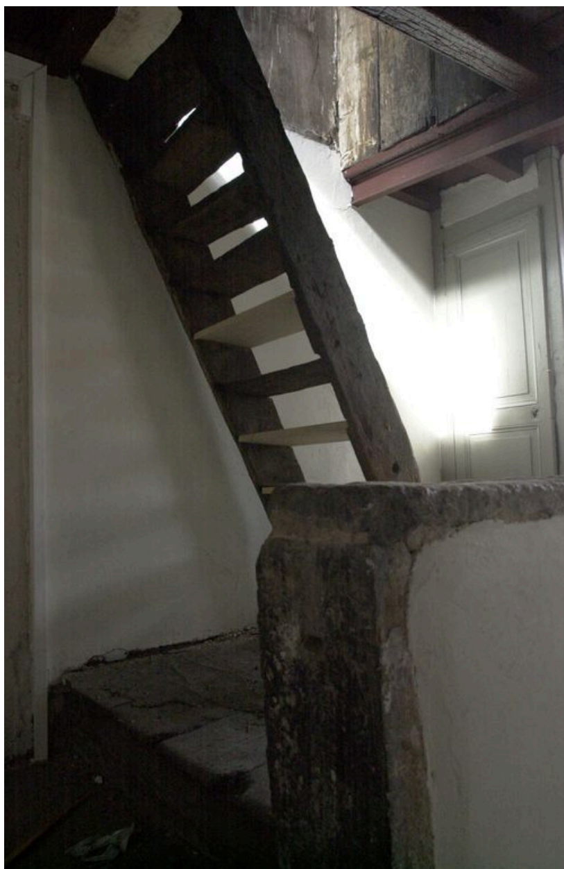
L'échelle de meunier d'accès aux combles
