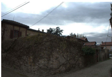
Vue de l'ensemble des maisons depuis l'est Phot. Catherine Guégan IVR82_20086900147NUCA
