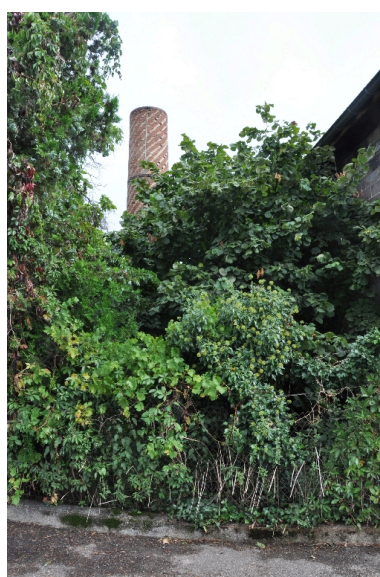
Vue de la cheminée présente sur le site Phot. Yannick Milleret IVR82_20127301839NUCA
