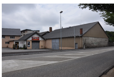
Vue générale du site Phot. Yannick Milleret IVR82_20127301838NUCA
