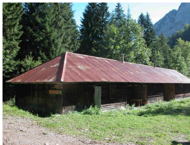
Vue de trois-quarts sud-est Phot. Thierry Monnet IVR84_20167400653NUCA
