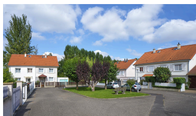
Organisation en îlots, autour d'une petite place, des maisons de la cité. Phot. Franck Trabouillet IVR84_20246302232NUCA
