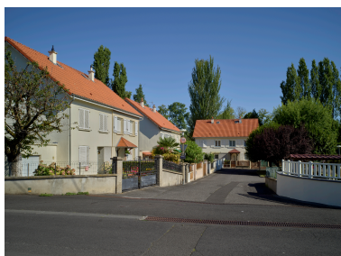
Maisons doubles de l'impasse de Villedry ouvrant sur la rue de Massaud. Phot. Christian Parisey IVR84_20206300947NUC4A
