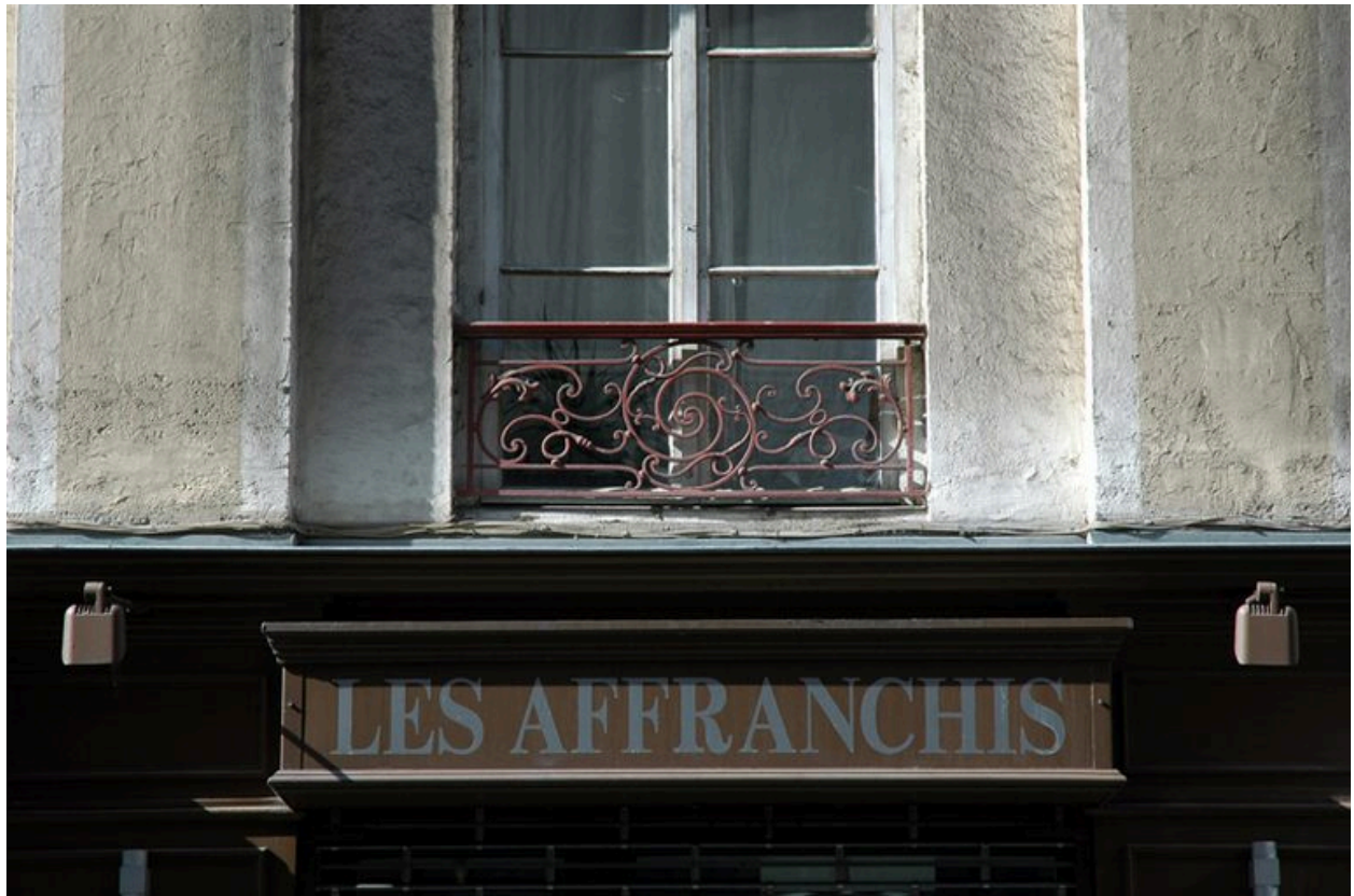
Élévation antérieure : garde-corps de l'entresol
