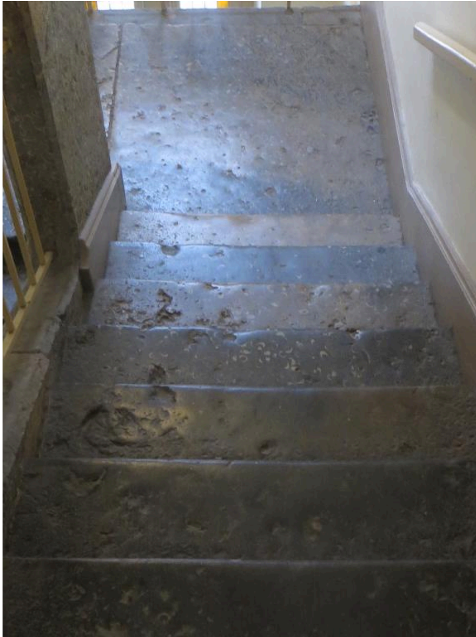
L'escalier : marches et vue partielle d'un repos
