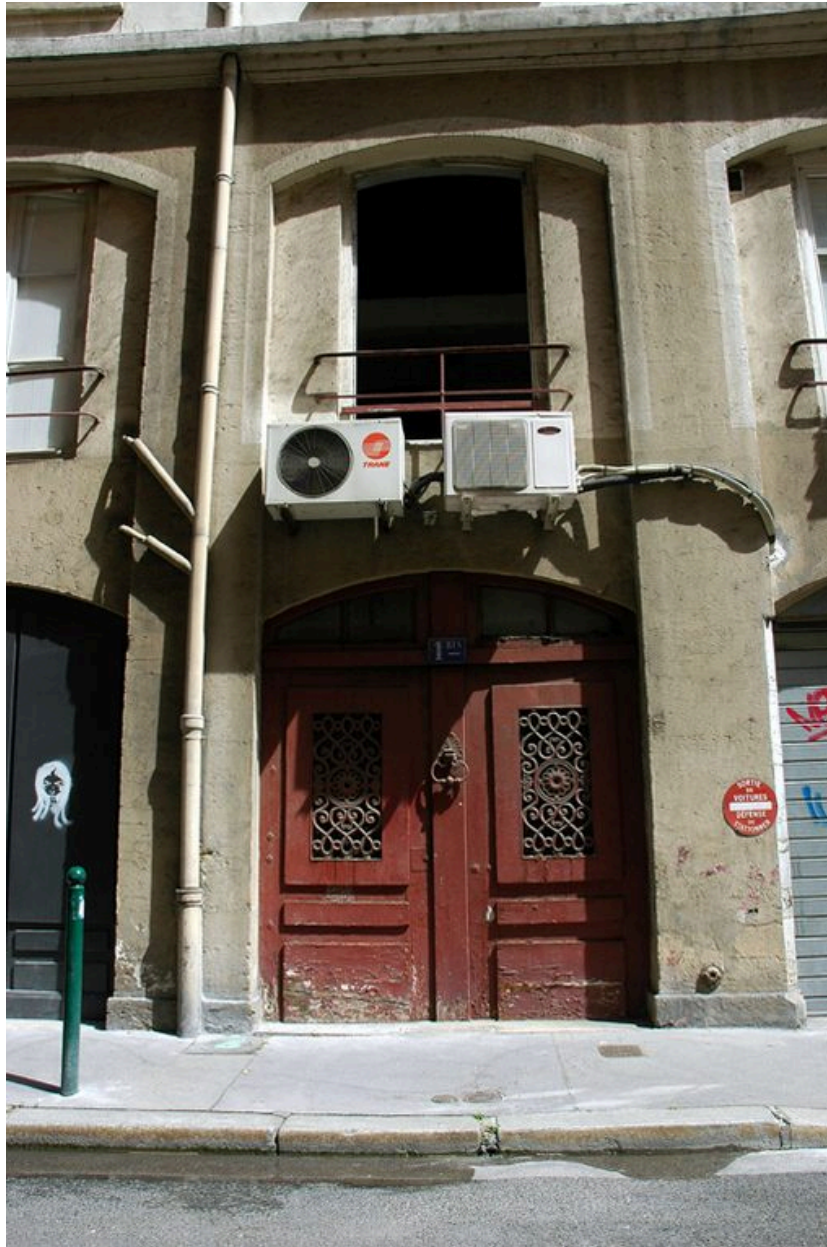
Elévation postérieure : porte cochère et entresol
