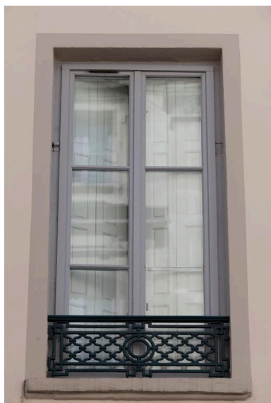
Elévation antérieure : fenêtre des étages carrés Phot. Michel Pérès IVR84_20206901147NUCA
