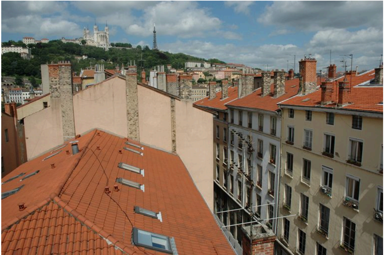
Elévation postérieure vue depuis le dernier étage du 6 rue des Templiers
