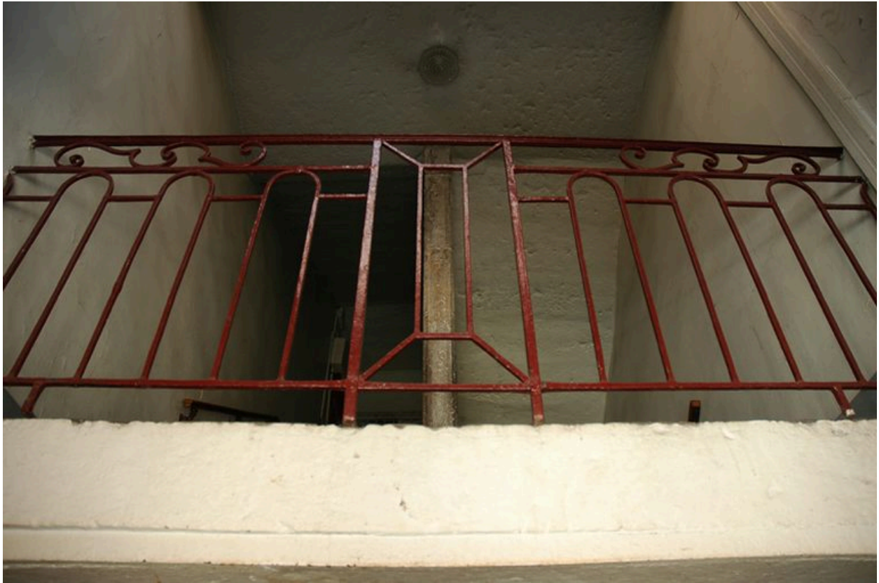
L'escalier : détail du garde-corps des repos
