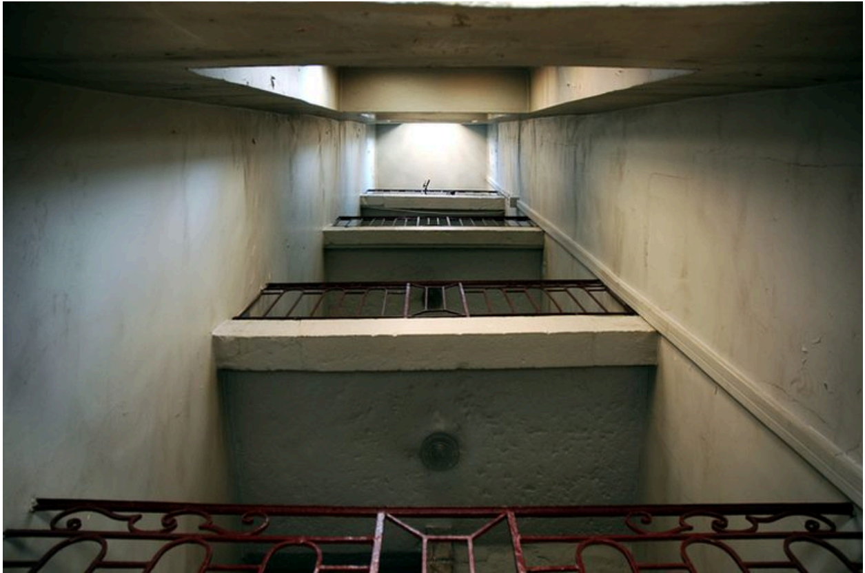
Le vide de la cage d'escalier, côté rue d'Amboise
