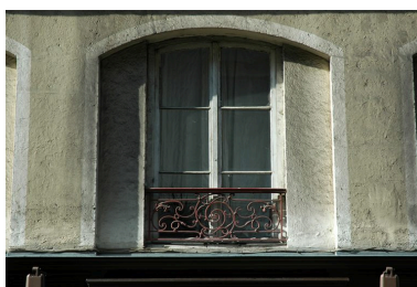
Elévation antérieure : baie de l'entresol Phot. Véronique Belle IVR82_20066901512NUCA
