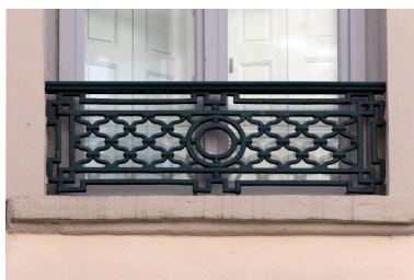
Elévation antérieure, étages carrés : garde-corps constitué d'un réseau de losanges curvilignes Phot. Michel Pérès IVR84_20206901146NUCA
