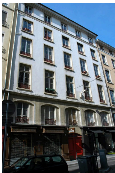
Vue générale, rue Gaspard-André Phot. Véronique Belle IVR82_20066901514NUCA
