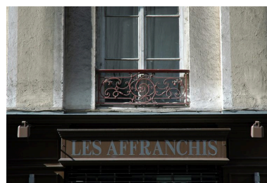
Elévation antérieure : garde-corps de l'entresol Phot. Véronique Belle IVR82_20066901513NUCA
