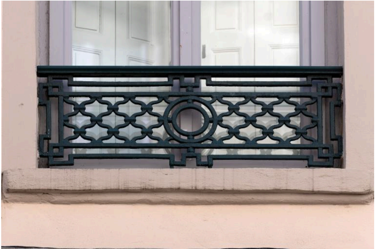
Elévation antérieure, étages carrés : garde-corps constitué d'un réseau de losanges curvilignes
