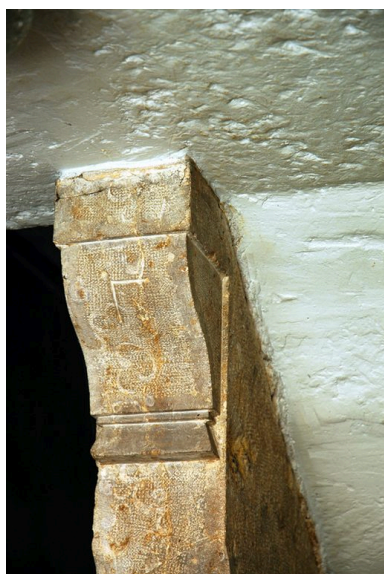
L'escalier : détail d'une console du mur-noyau Phot. Véronique Belle IVR82_20066901518NUCA
