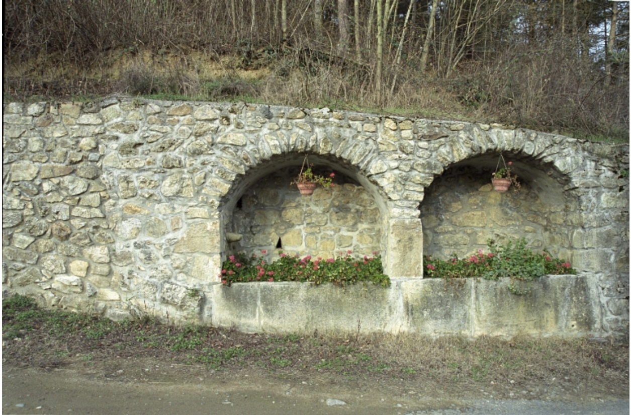
Vue d'ensemble de deux bassins sous arcade, anciennement avec fontaine (1987 A1 1512).
