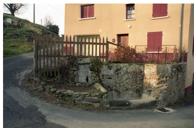
Vue d'ensemble d'un petit bassin, anciennement avec fontaine (1987 A1 691). Phot. Thierry Monnet IVR82_20044202012ZE
