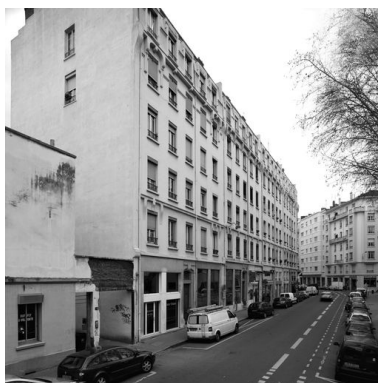
Vue d'ensemble depuis le sud-est Phot. Eric Dessert IVR82_20076901321NUC
