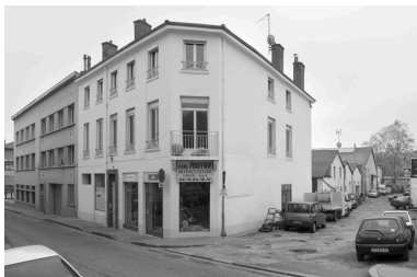
Vue générale nord-ouest (angle Bourbonnais-Béal) Phot. Didier Gourbin IVR82_20066902735NUCA
