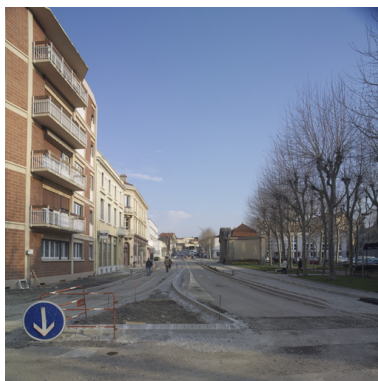
Vue de situation de l'emplacement de la caserne Phot. Eric Dessert IVR82_20084200752NUCA
