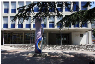
Vue d'ensemble Phot. Etudiants de l'Ecole Saint-Luc, Liège IVR84_20252600441NUCA
