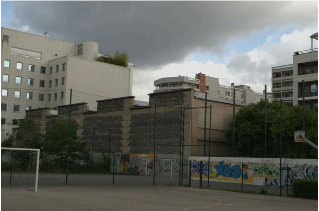
Vue est : détail toiture, série de 5 lanterneaux
