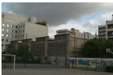
Vue est : détail toiture, série de 5 lanterneaux Phot. Nadine Halitim-Dubois IVR82_20086900387NUCA
