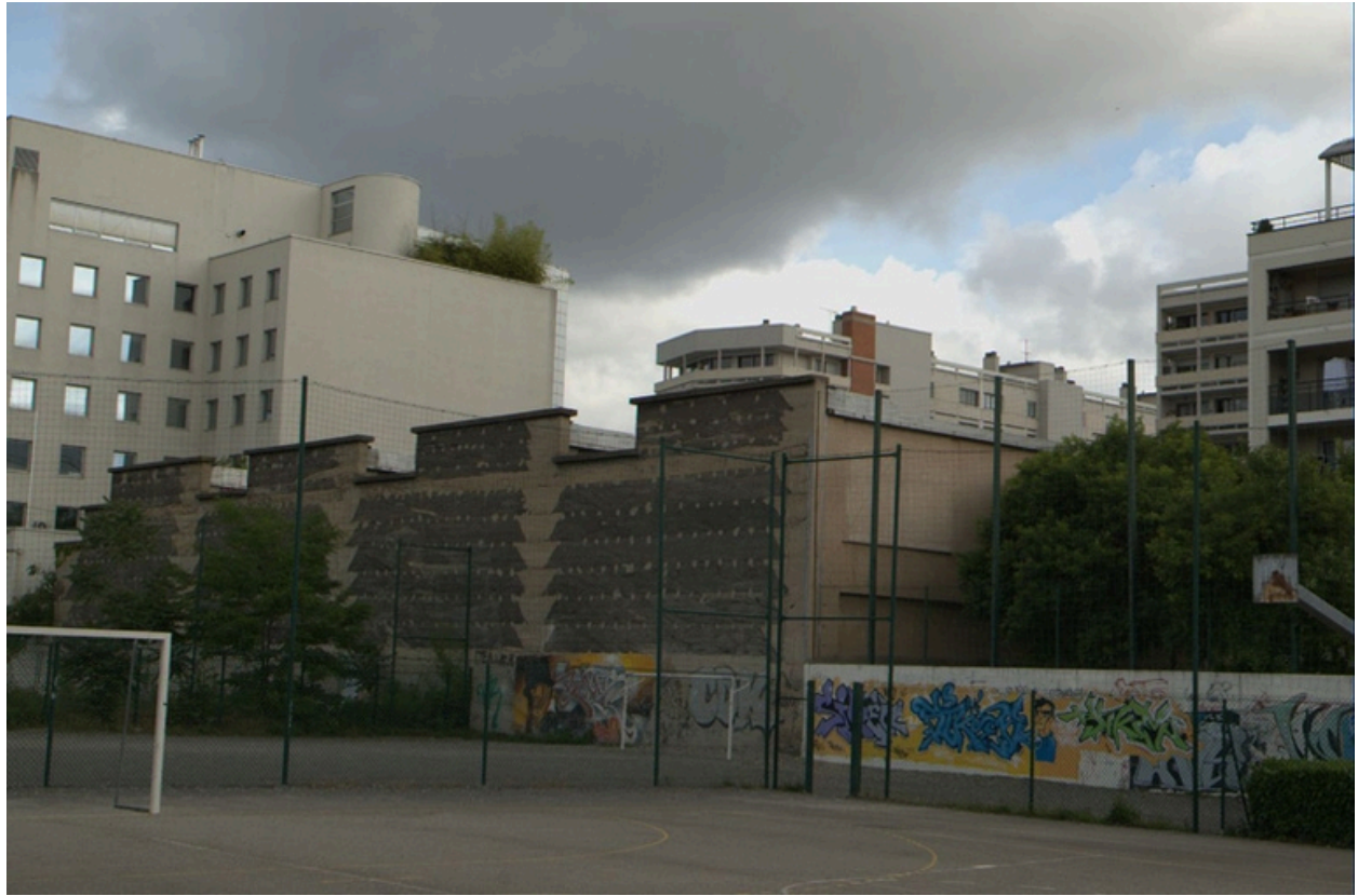
Vue est : détail toiture, série de 5 lanterneaux
