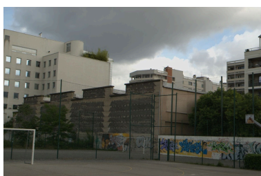
Vue est : détail toiture, série de 5 lanternes Phot. Nadine Halitim-Dubois IVR82_20086900387NUCA
