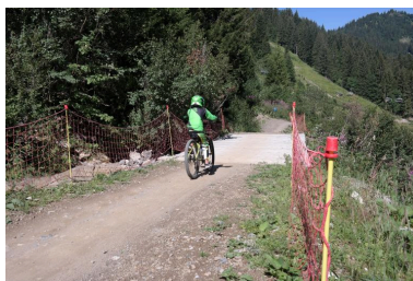
Passerelle VTT de Plaine Dranse avec pratiquant Phot. Pascale Renard IVR84_20207401424NUCA
