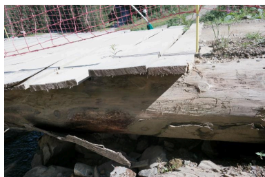
Passerelle VTT de Plaine Dranse, détail de la structure Phot. Pascale Renard IVR84_20207401423NUCA
