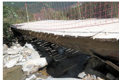
Passerelle VTT de Plaine dranse, vue de la face amont Phot. Pascale Renard IVR84_20207401422NUCA
