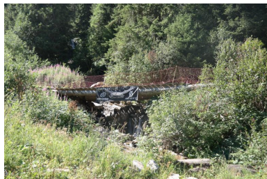
Passerelle VTT de Plaine Dranse, vue de la face aval Phot. Pascale Renard IVR84_20197401241NUCA
