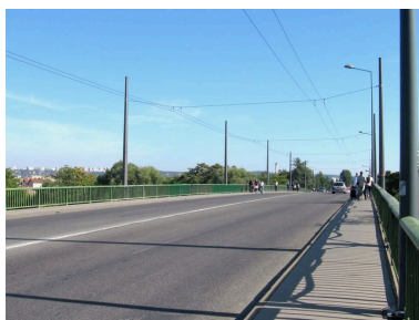
Chaussée (depuis la rive gauche) Phot. I. Havard IVR82_20106907013NUCA
