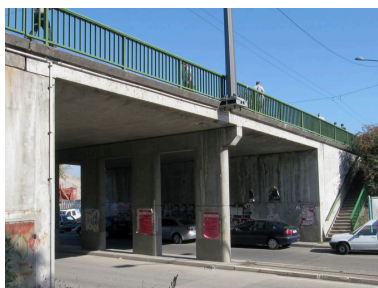
Culée de la rive droite, face amont Phot. I. Havard IVR82_20106907010NUCA
