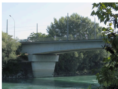
Vue partielle, face aval (depuis la rive gauche) Phot. I. Havard IVR82_20106907012NUCA
