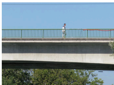
Tablier et parapet, vue partielle, face amont (depuis la rive droite) Phot. I. Havard IVR82_20106907009NUCA
