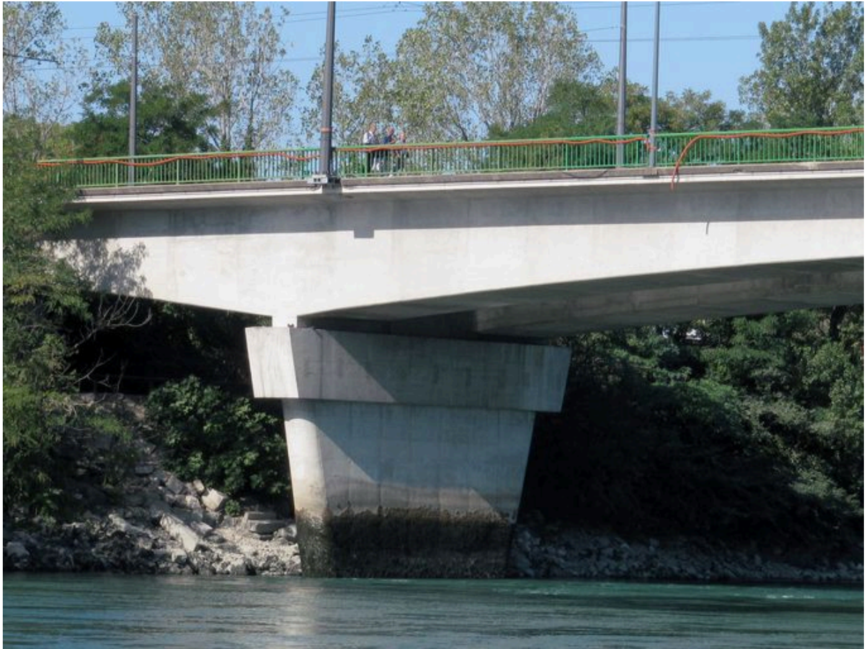
Pile, face amont (depuis la rive droite)
