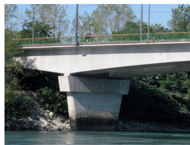
Pile, face amont (depuis la rive droite) Phot. I. Havard IVR82_20106907008NUCA
