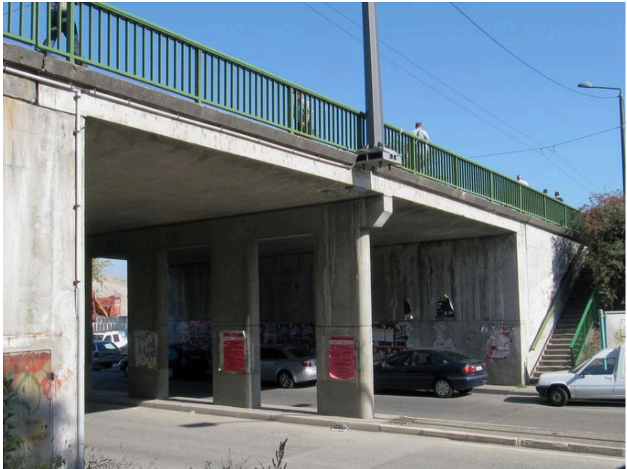
Culée de la rive droite, face amont
